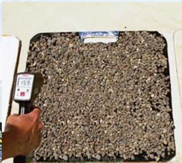
Manto prefabricado con gravilla a 71°C
