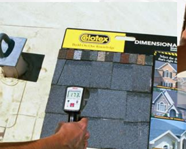
Membrana asfáltica a 78°C
