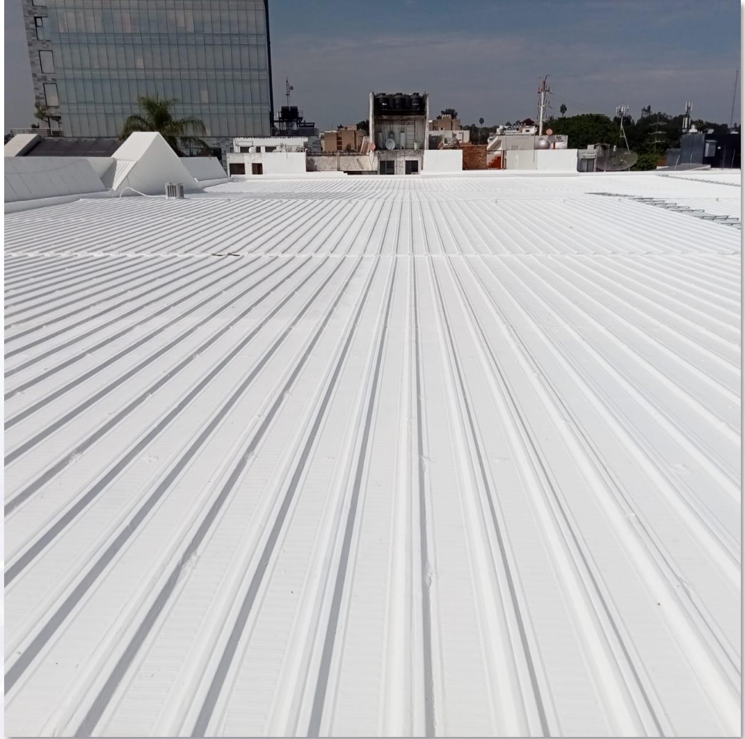
Cubierta terminada con Sistema Enduris*
