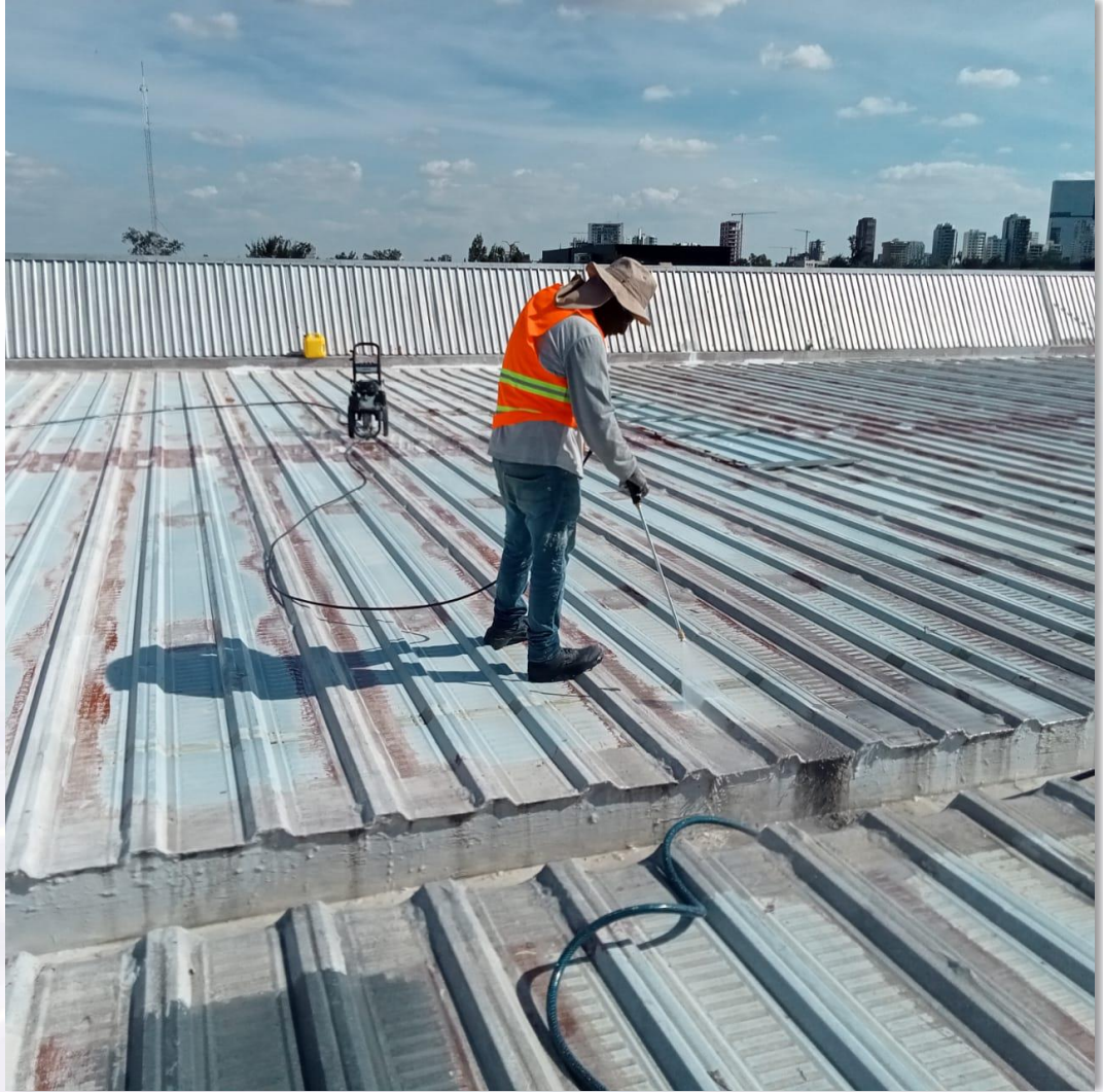
Cubierta durante los trabajos de limpieza
