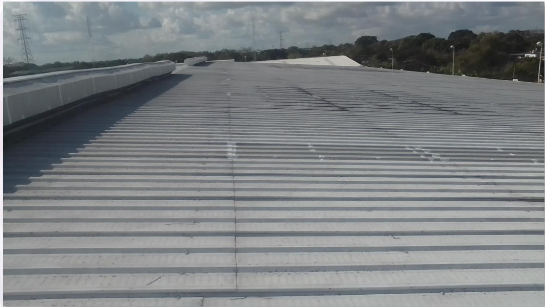
Cubierta durante los trabajos de limpieza
