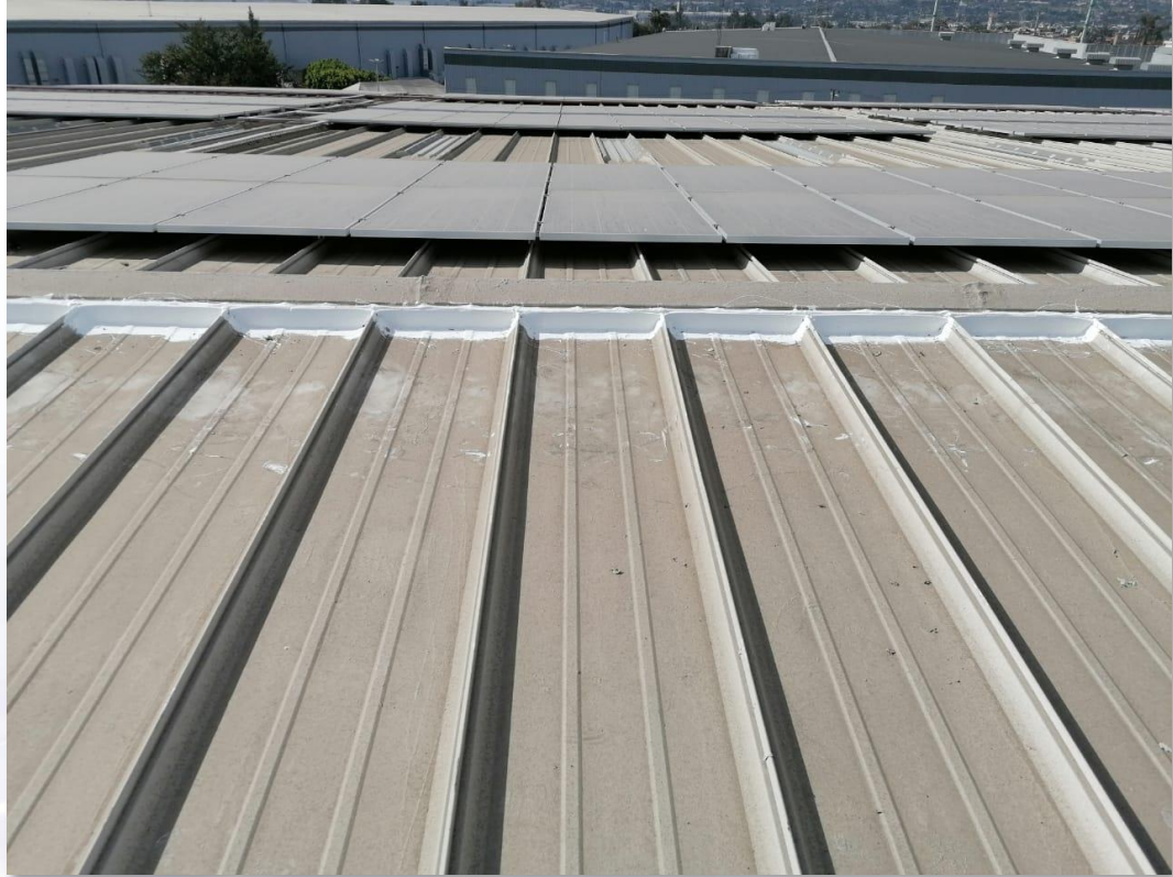
Cubierta durante los trabajos de limpieza
