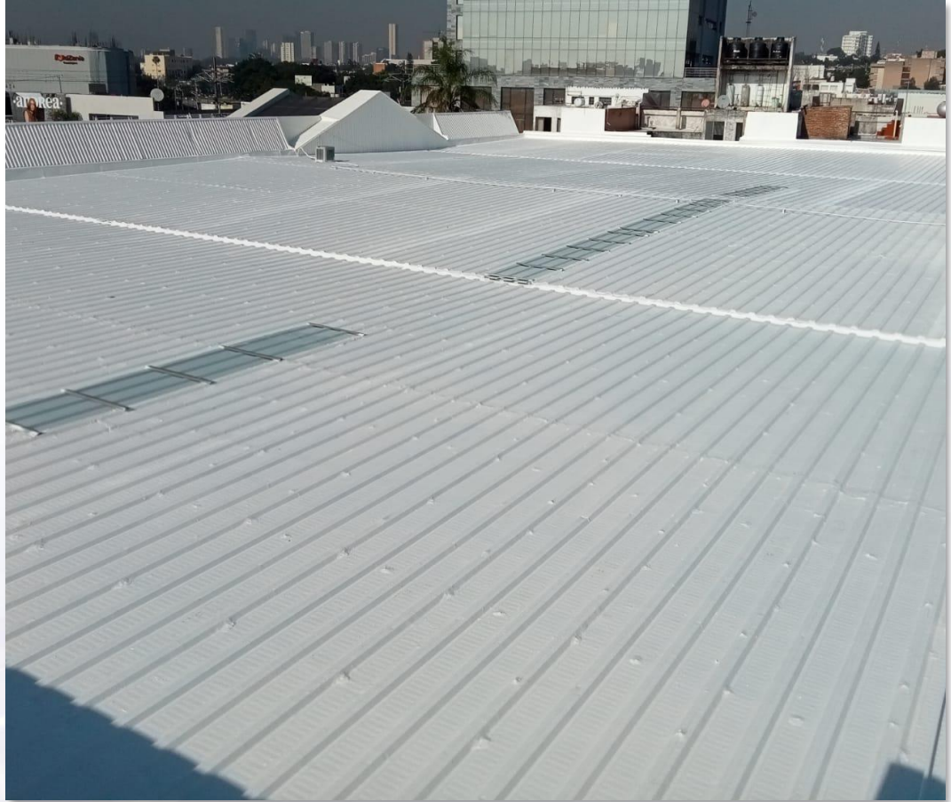
Cubierta terminada con Sistema Enduris*
