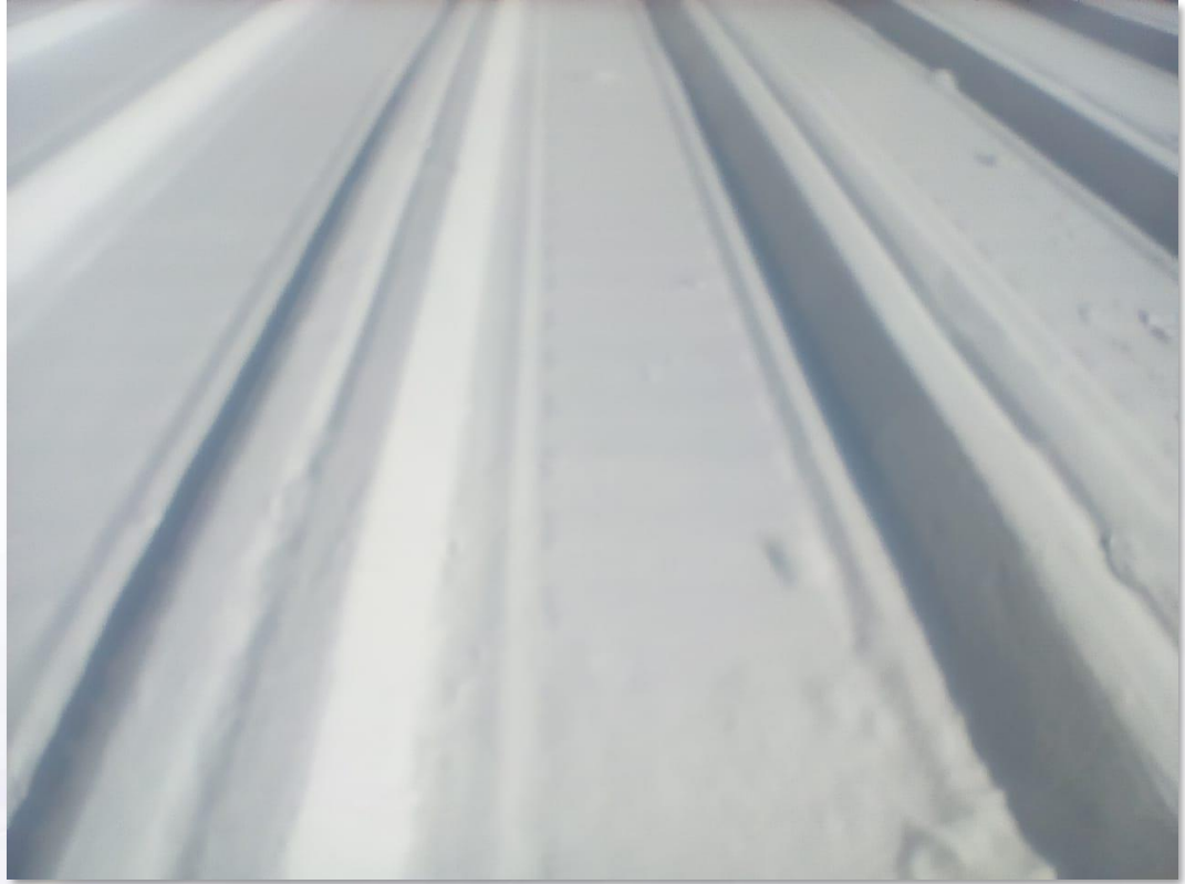
Cubierta terminada con Sistema Enduris*
