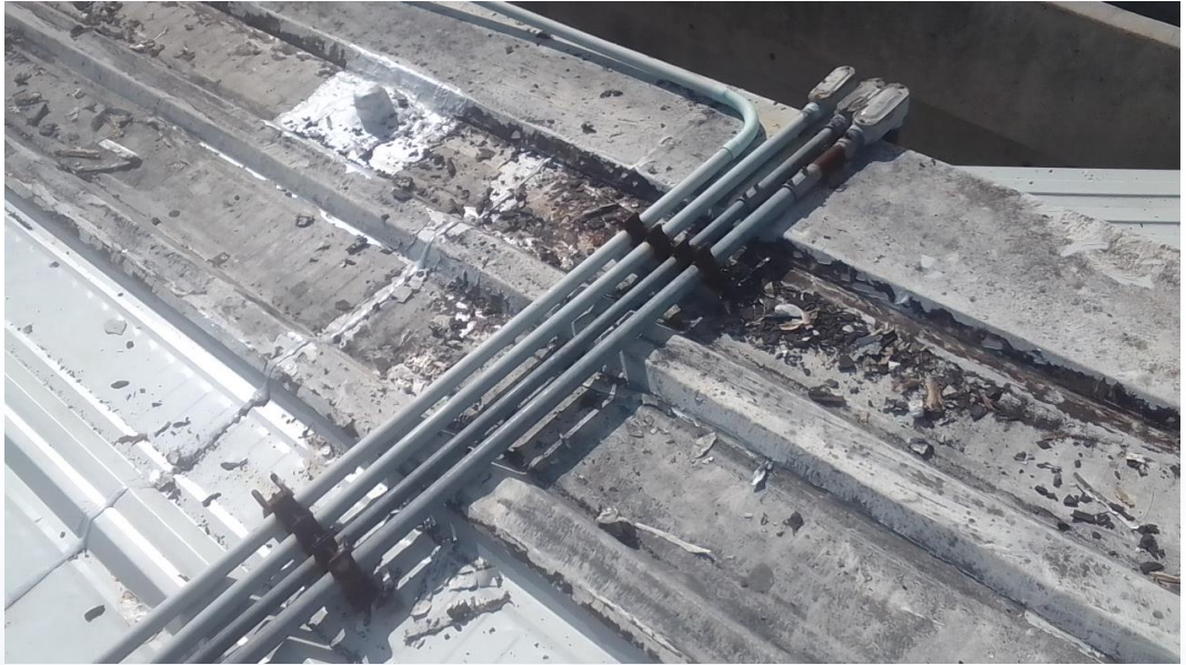
Cubierta durante los trabajos de limpieza
