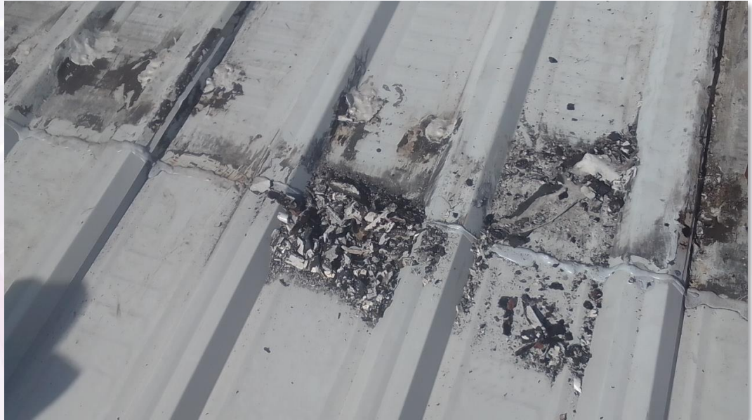
Cubierta durante los trabajos de limpieza
