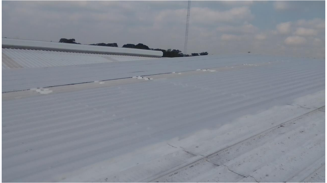
Cubierta terminada con Sistema Enduris*
