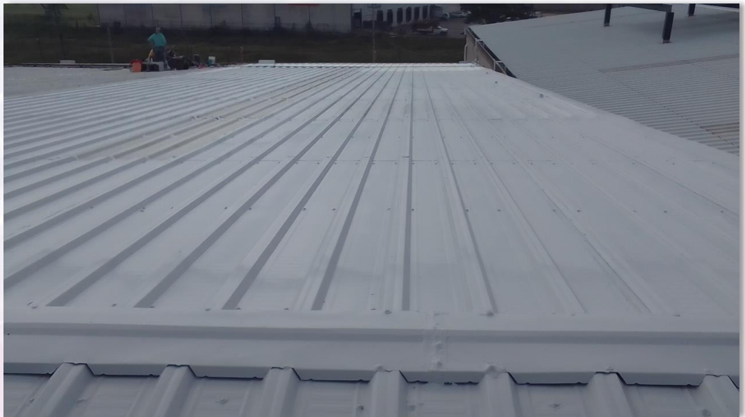
Cubierta terminada con Sistema Enduris*
