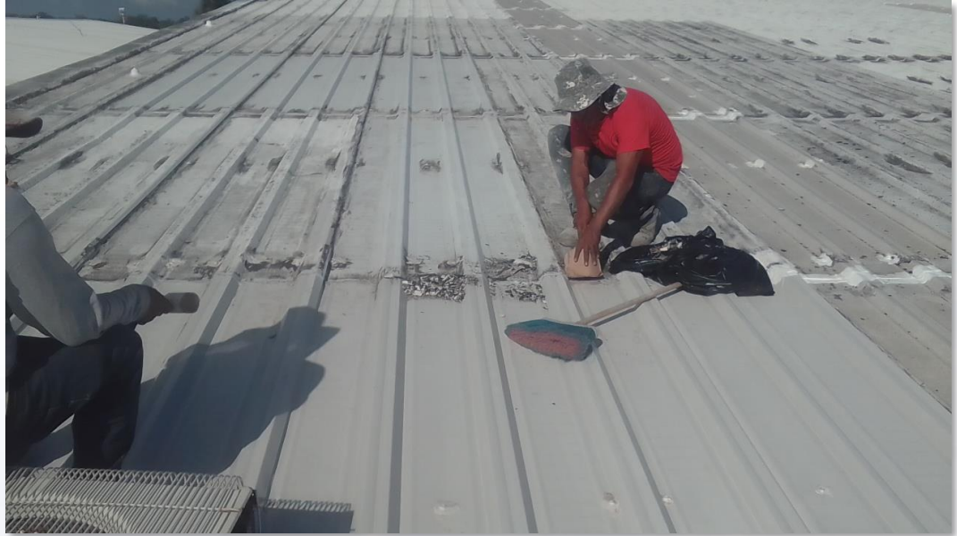
Cubierta durante los trabajos de limpieza
