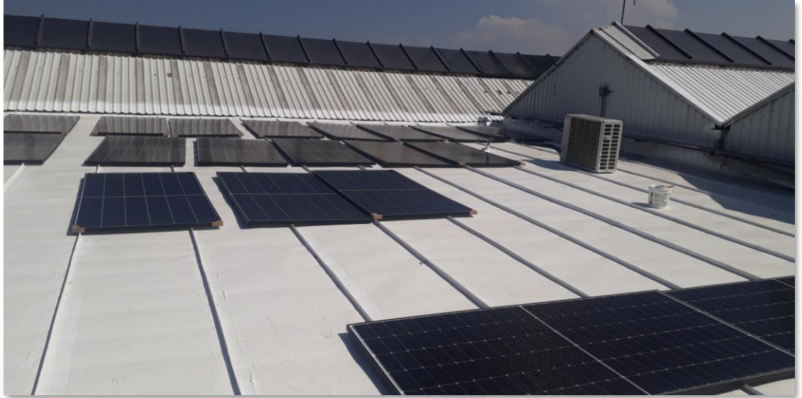
Cubierta terminada con Sistema Enduris*
