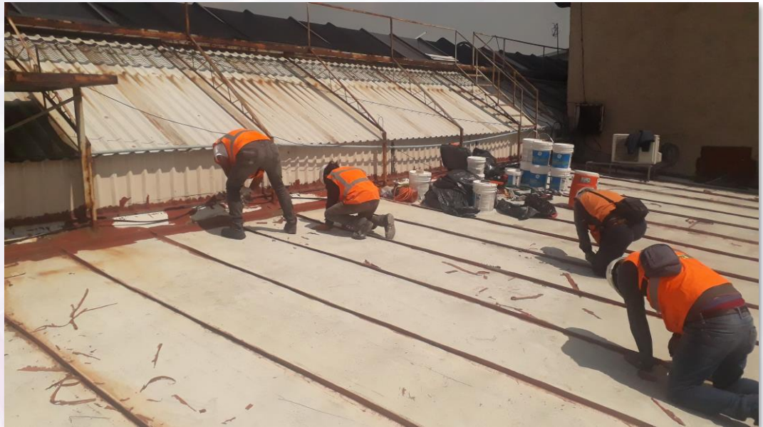
Cubierta durante los trabajos de limpieza
