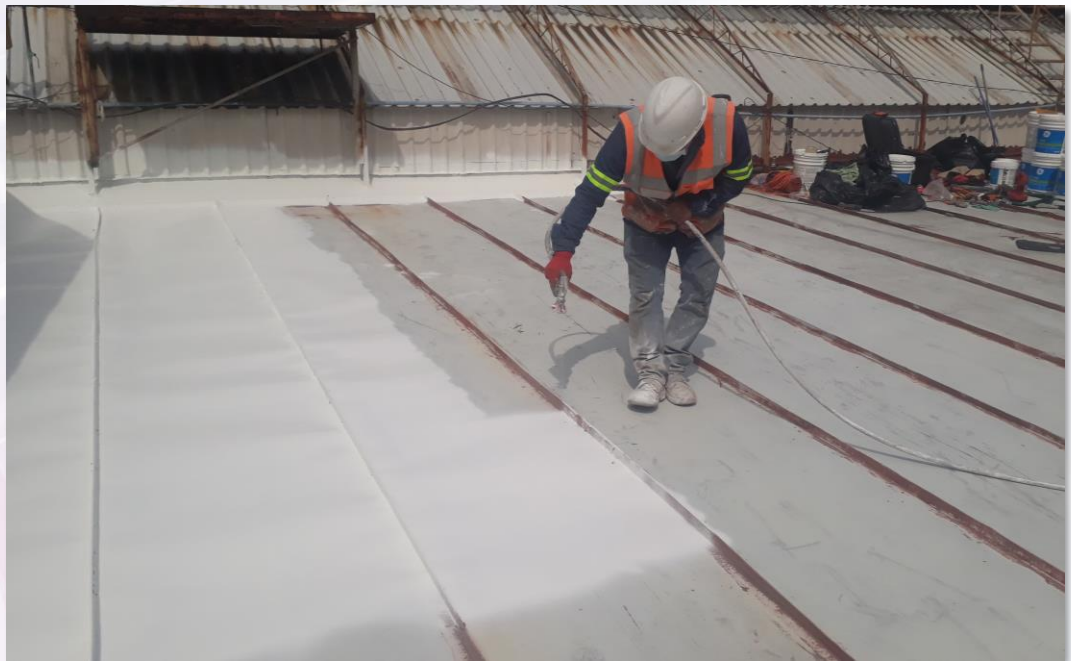
Aplicación de Sistema Enduris* con equipo Airless
