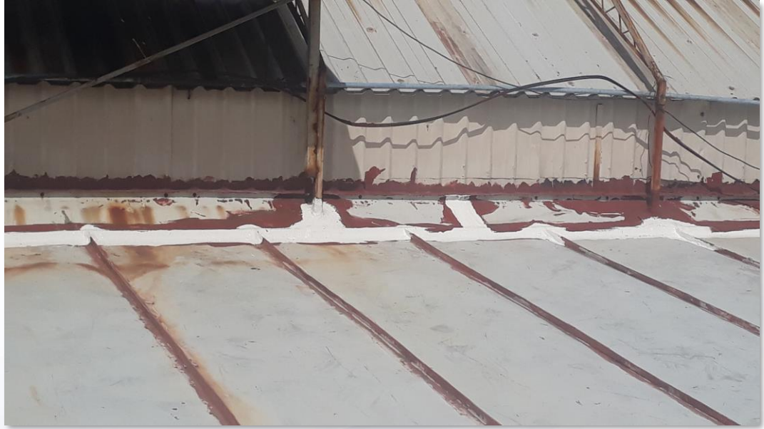
Cubierta después de los trabajos de limpieza
