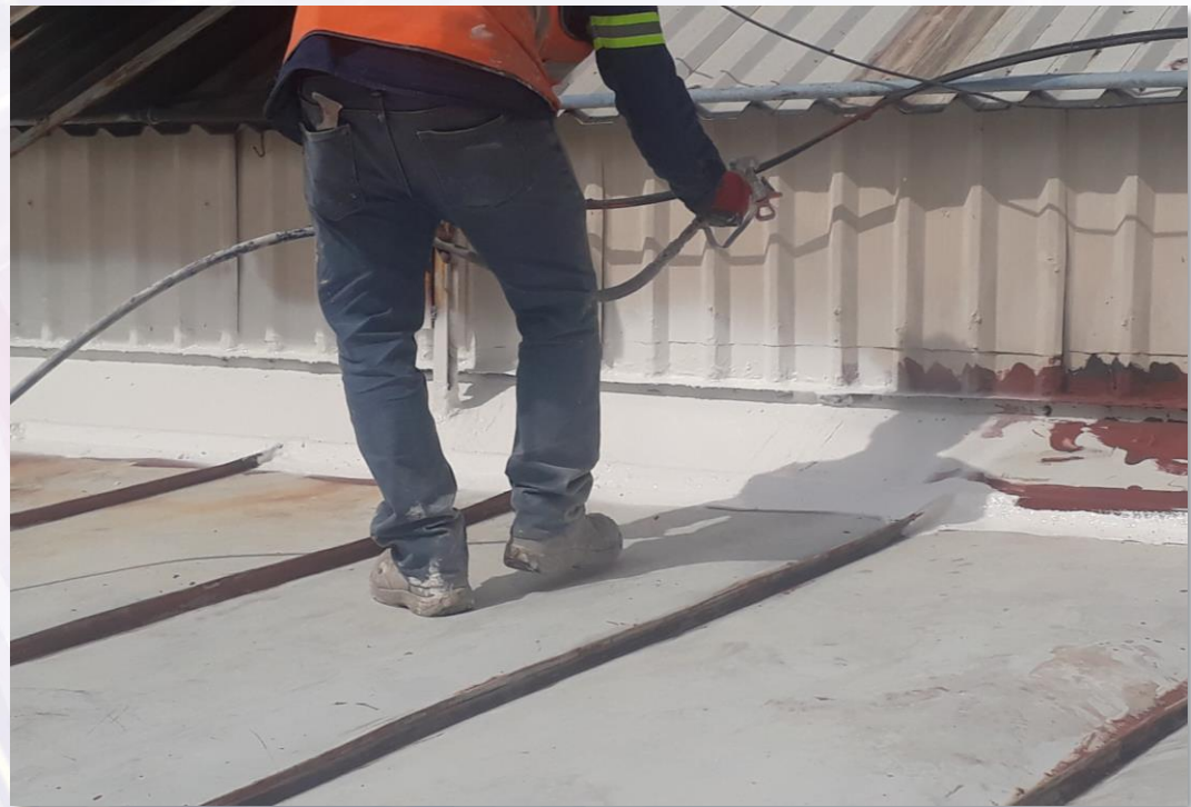
Aplicación de Sistema Enduris* con equipo Airless
