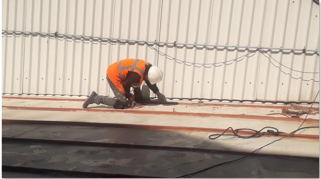
Cubierta durante los trabajos de limpieza
