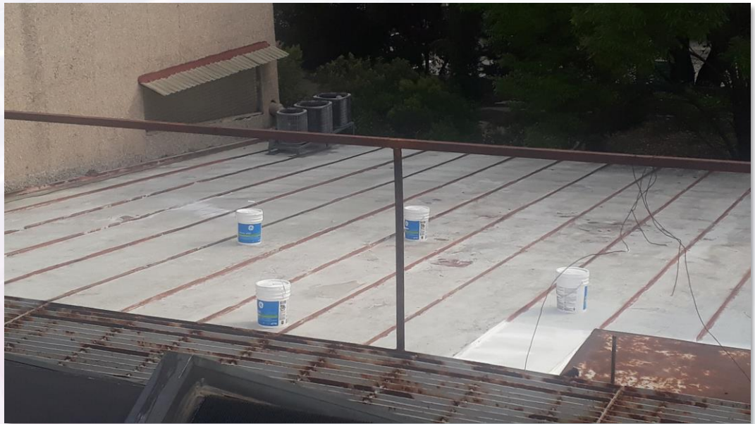
Cubierta después de los trabajos de limpieza
