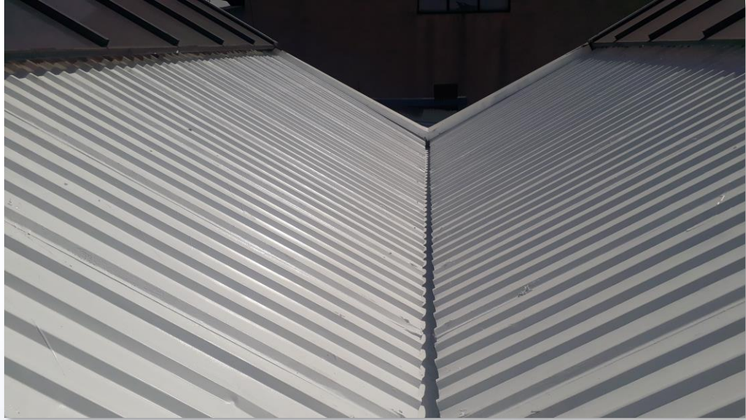
Cubierta terminada con Sistema Enduris*
