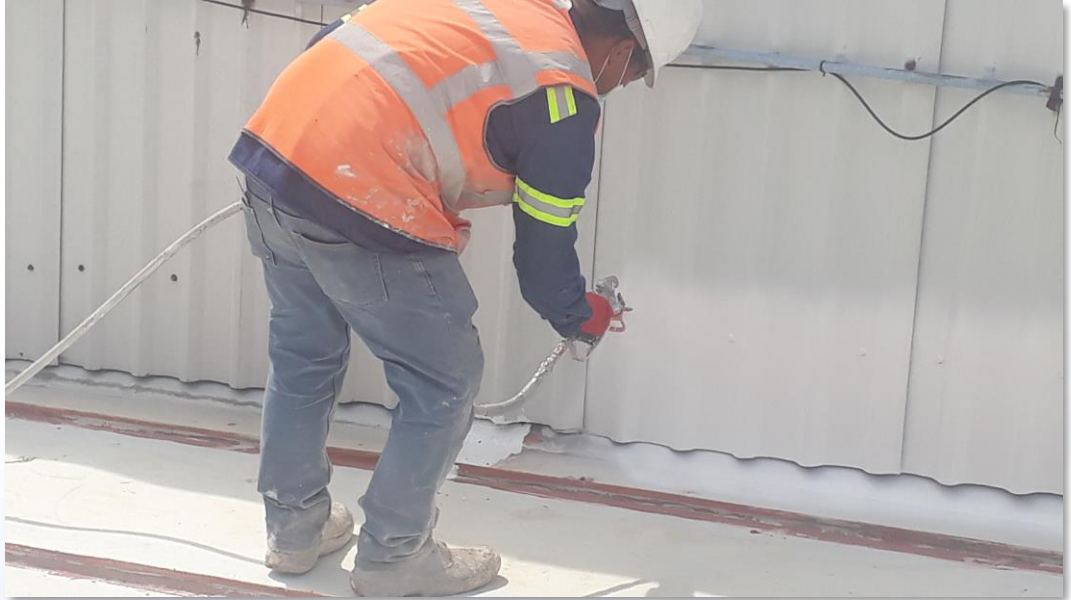
Aplicación de Sistema Enduris* con equipo Airless
