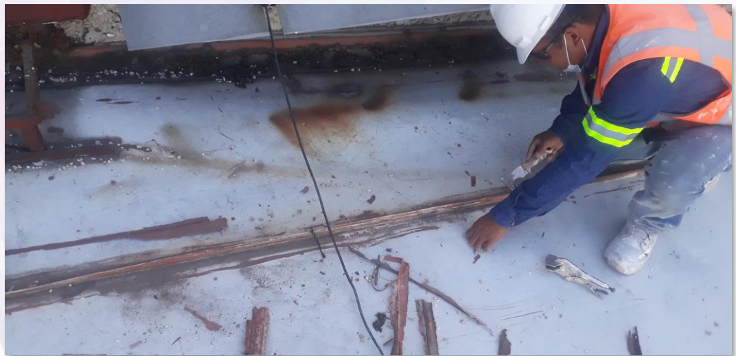
Cubierta antes de los trabajos de limpieza
