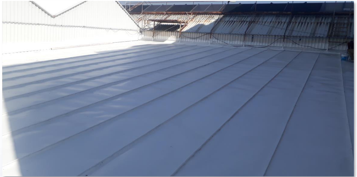
Cubierta terminada con Sistema Enduris*
