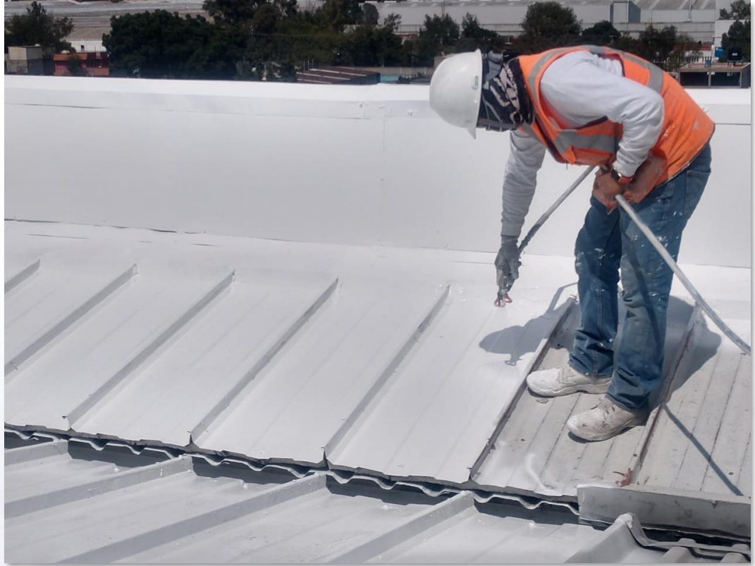
Aplicación de Sistema Enduris* con equipo Airless
