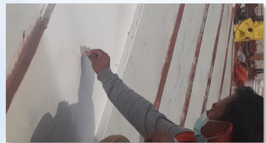
Espesor en fresco de 28 mils / 0.71 mm.
