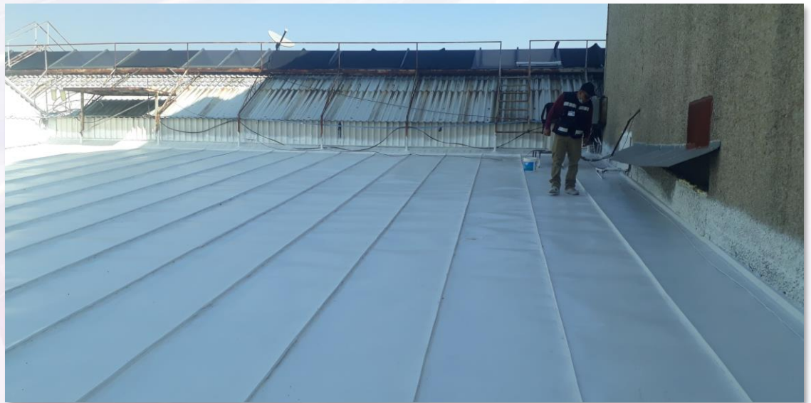
Cubierta terminada con Sistema Enduris*
