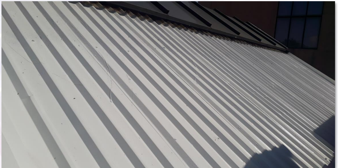
Cubierta terminada con Sistema Enduris*
