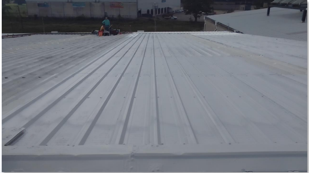
Cubierta terminada con Sistema Enduris*
