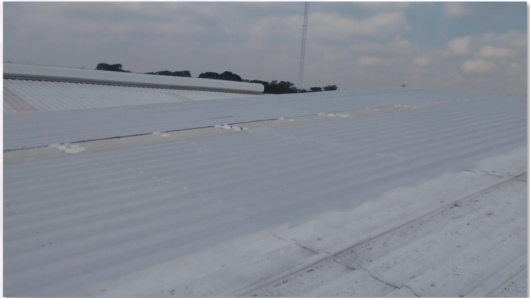
Cubierta durante la aplicación del Sistema Enduris*
