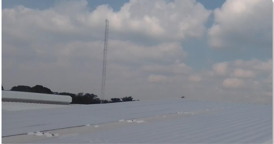
Cubierta terminada con Sistema Enduris*
