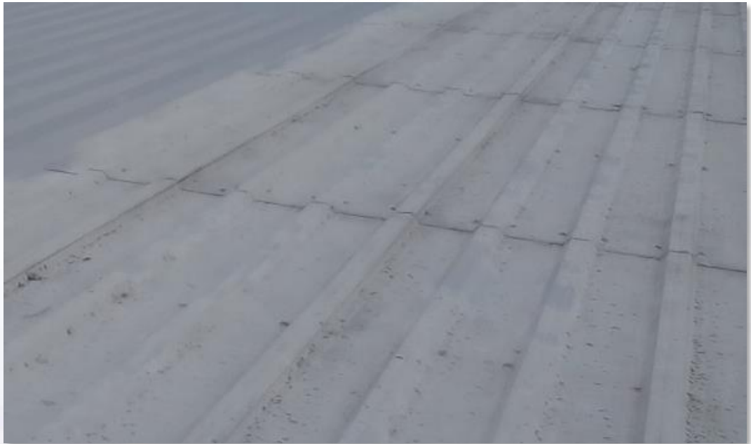
Cubierta antes de la aplicación del Sistema Enduris*
