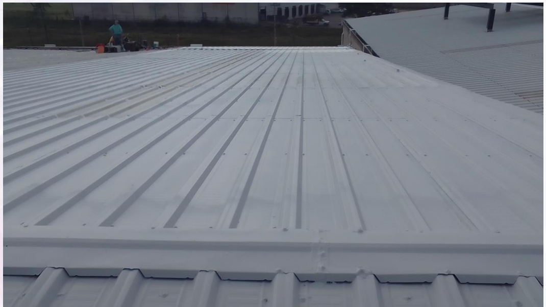
Cubierta terminada con Sistema Enduris*
