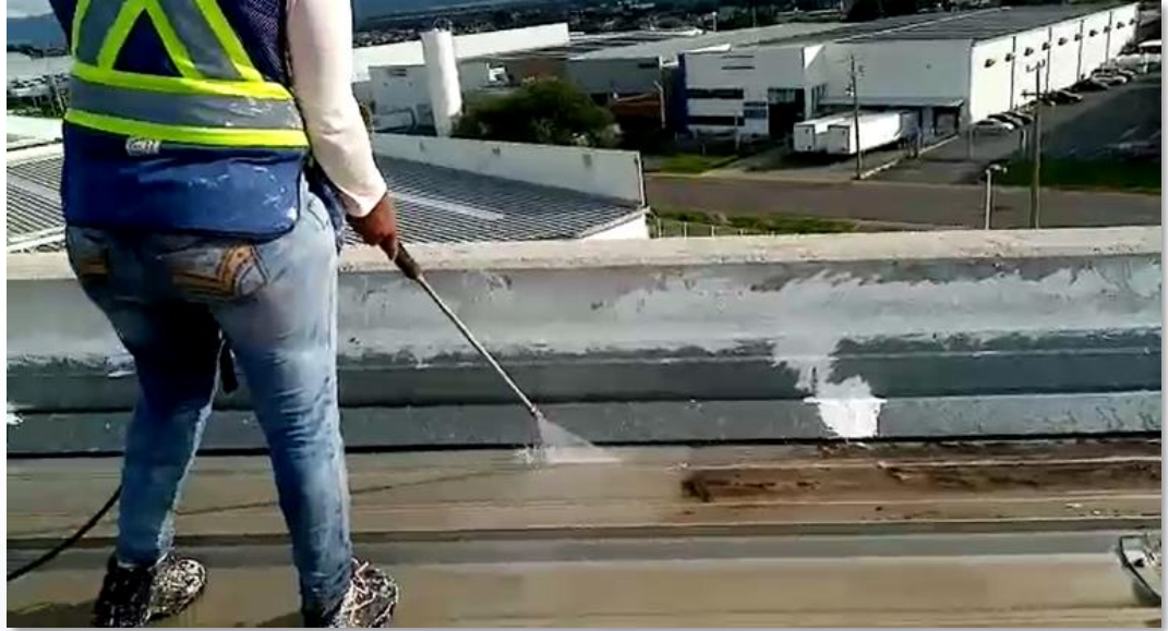
Proceso de limpieza con equipo de alta presión
