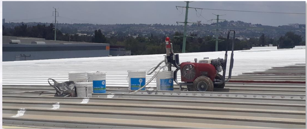
Aplicación de Sistema Enduris* con equipo Airless
