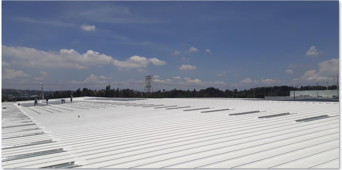
Cubierta terminada con Sistema Enduris*
