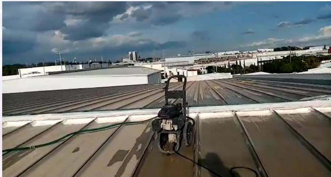
Cubierta después de los trabajos de limpieza
