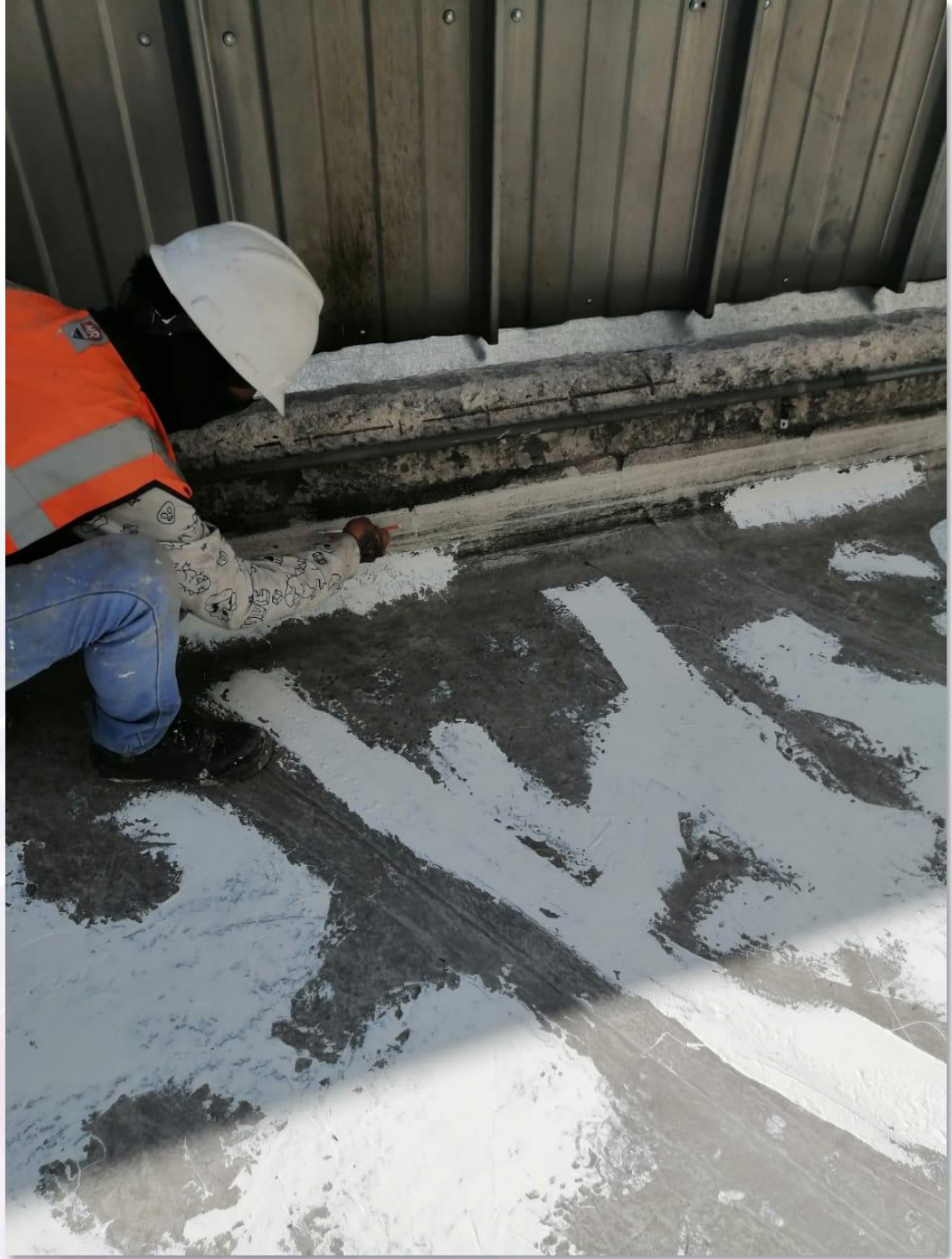
Aplicación de Enduris* Liquid Flashing
