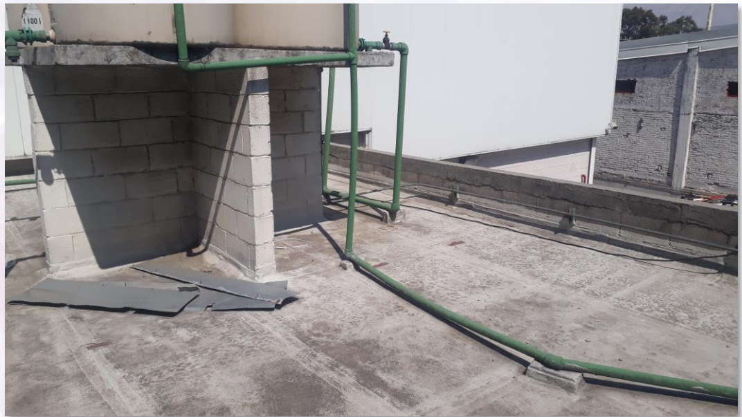
Cubierta antes de los trabajos de limpieza
