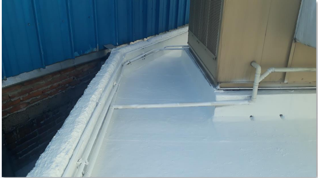
Cubierta terminada con Sistema Enduris*
