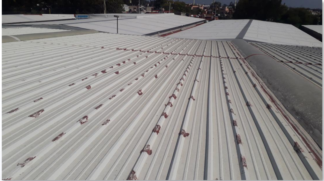
Cubierta durante los trabajos de limpieza
