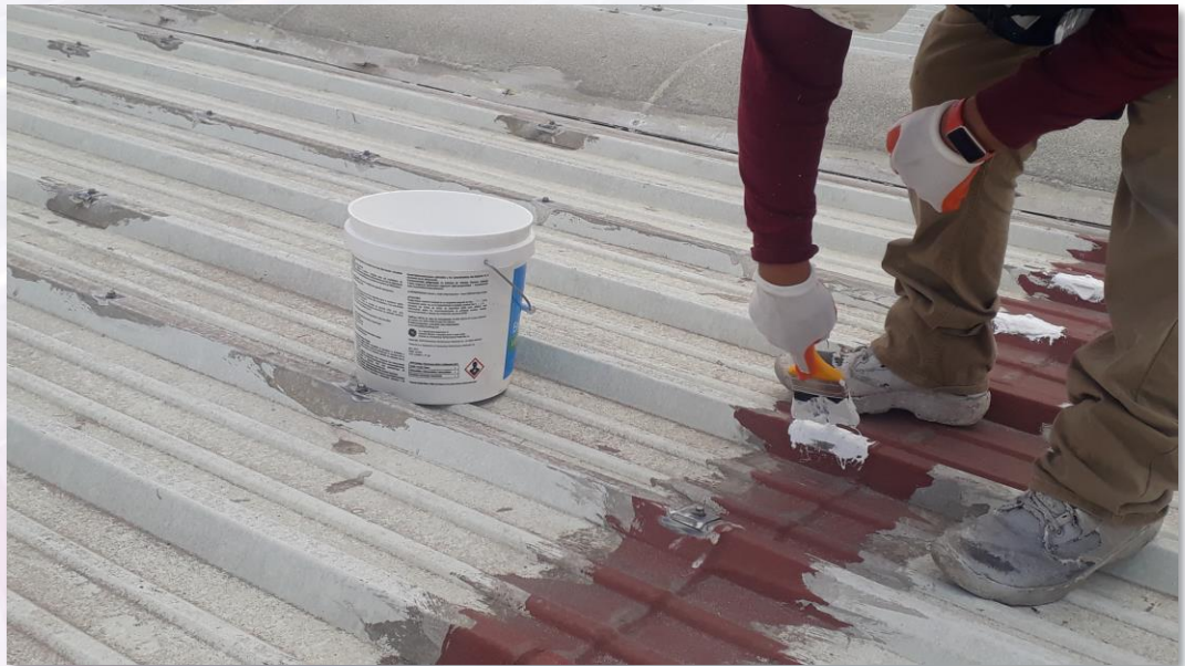
Aplicación de Enduris* Liquid Flashing
