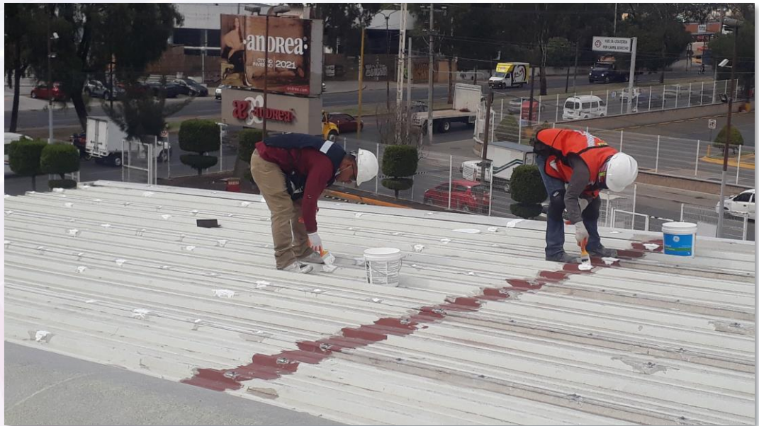
Aplicación de Enduris* Liquid Flashing
