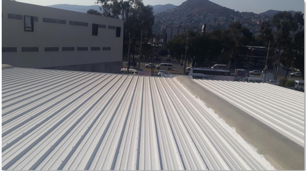
Cubierta terminada con Sistema Enduris*
