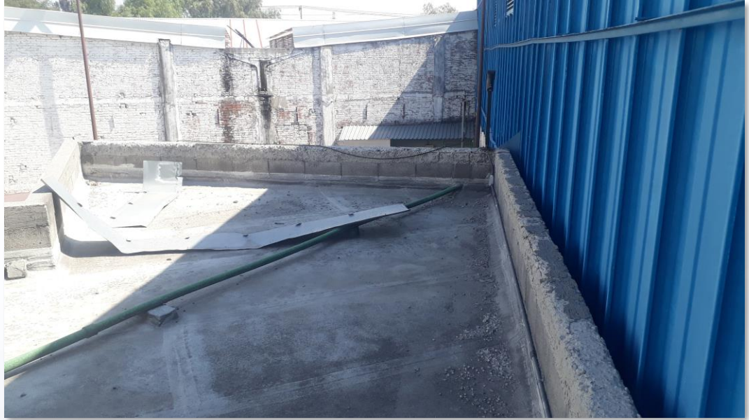
Cubierta antes de los trabajos de limpieza
