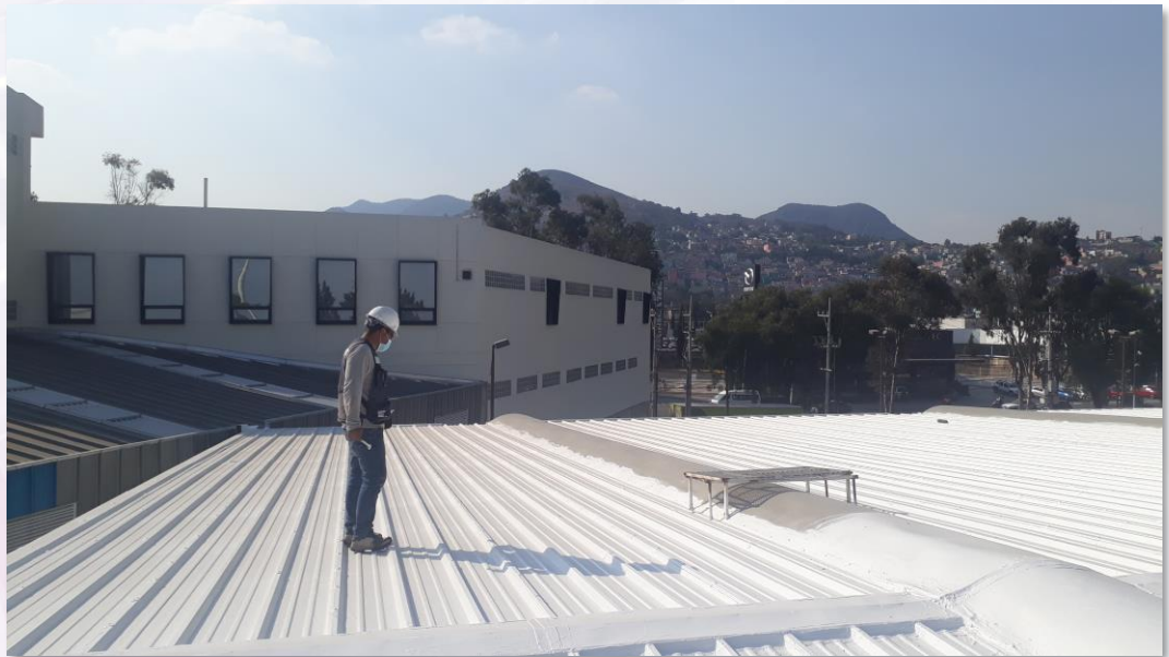
Cubierta terminada con Sistema Enduris*
