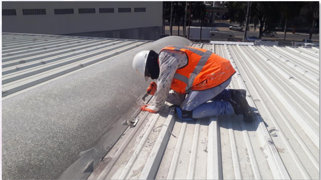
Cubierta durante los trabajos de limpieza
