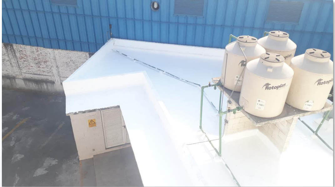
Cubierta terminada con Sistema Enduris*
