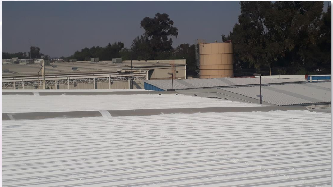
Cubierta terminada con Sistema Enduris*
