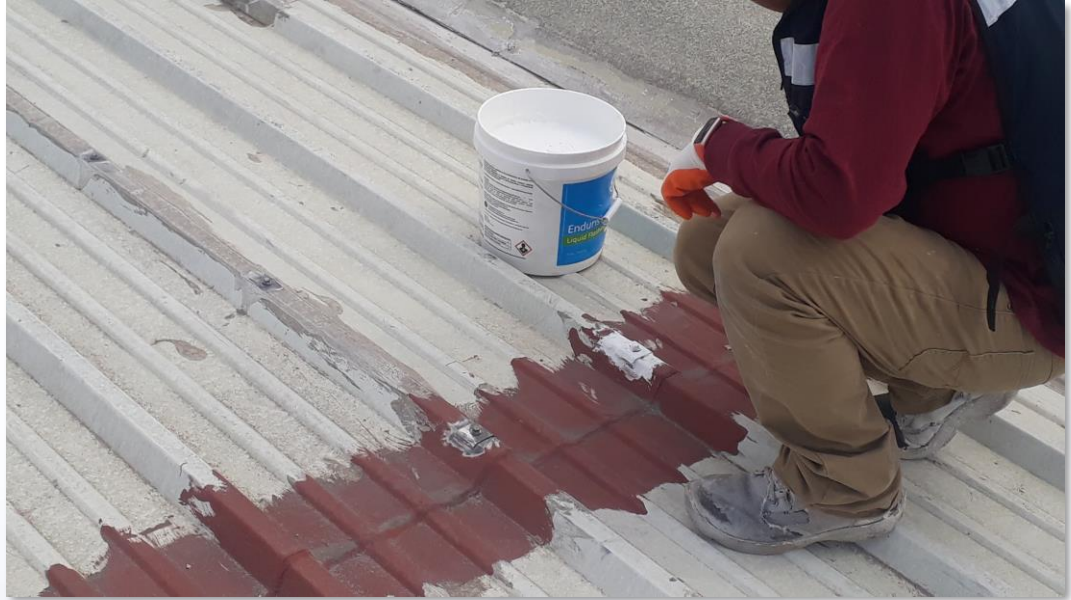
Aplicación de Enduris* Liquid Flashing
