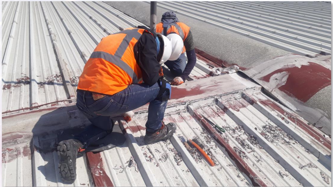
Cubierta durante los trabajos de limpieza
