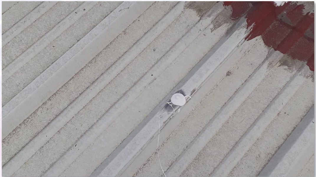
Aplicación de Enduris* Liquid Flashing
