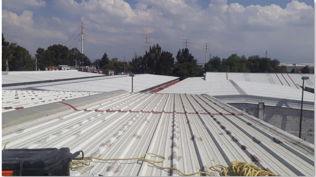
Cubierta durante los trabajos de limpieza
