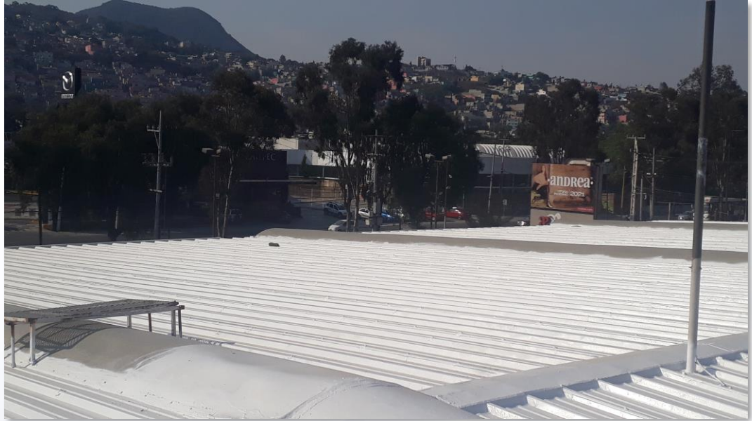
Cubierta terminada con Sistema Enduris*
