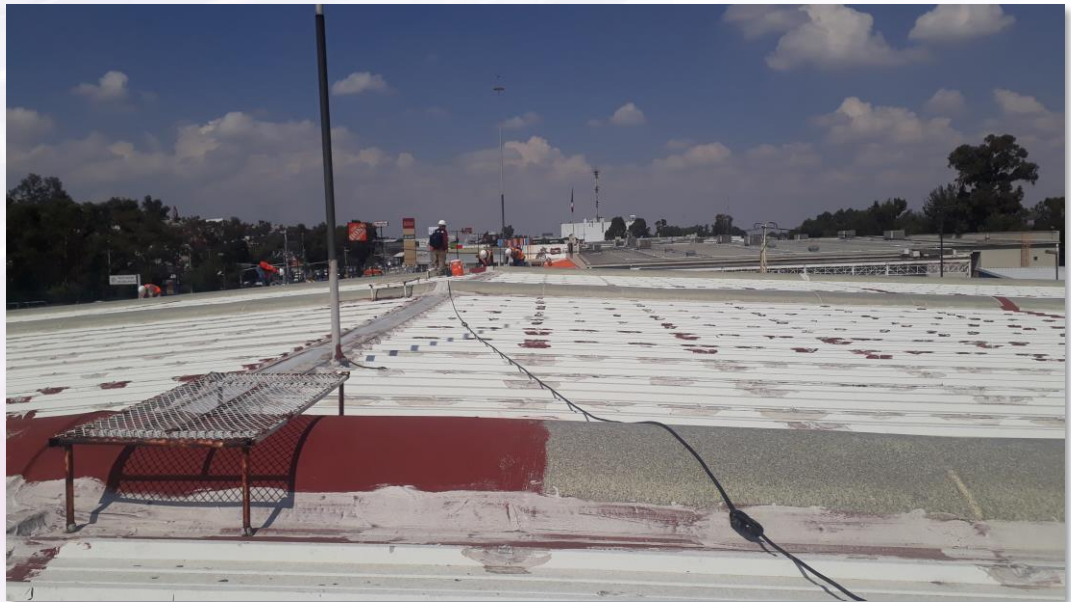
Cubierta antes de los trabajos de limpieza
