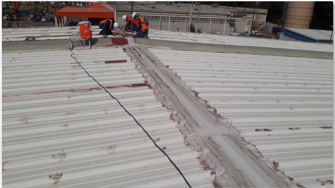
Cubierta durante los trabajos de limpieza
