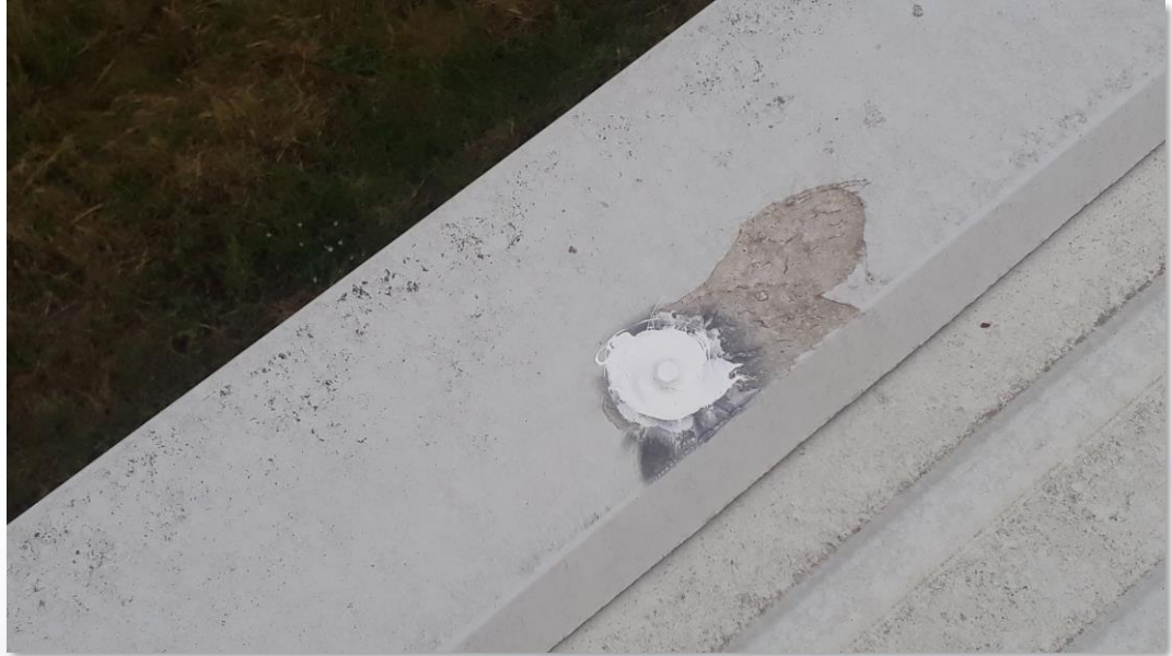
Aplicación de Enduris* Liquid Flashing
