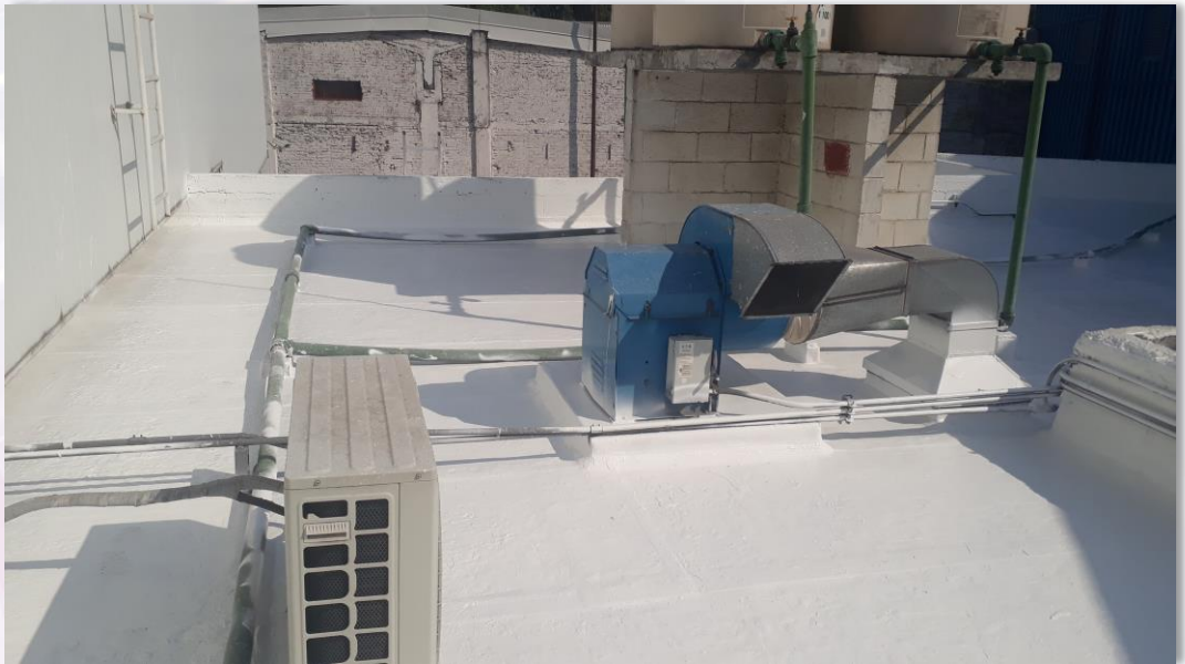
Cubierta terminada con Sistema Enduris*
