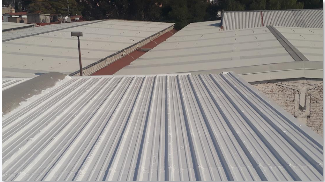
Cubierta terminada con Sistema Enduris*
