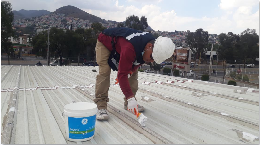
Aplicación de Enduris* Liquid Flashing
