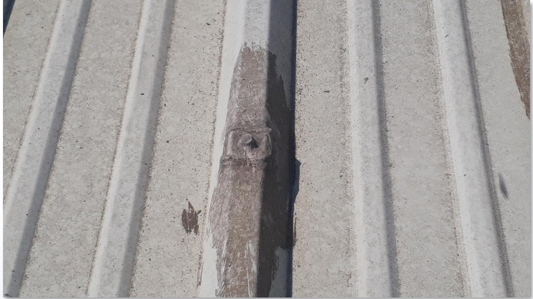
Cubierta durante los trabajos de limpieza
