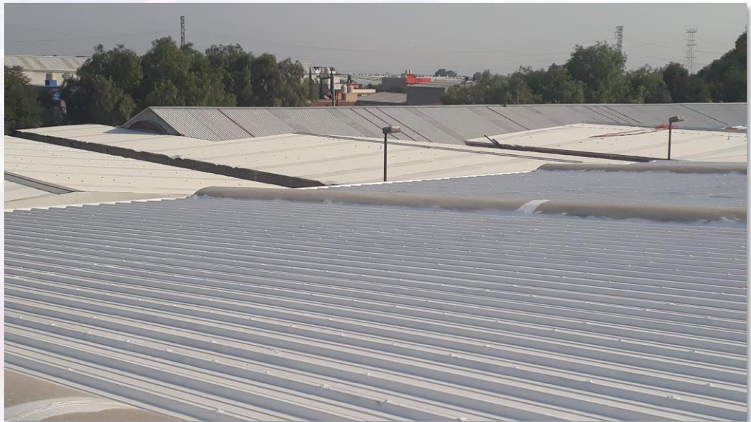
Cubierta terminada con Sistema Enduris*
