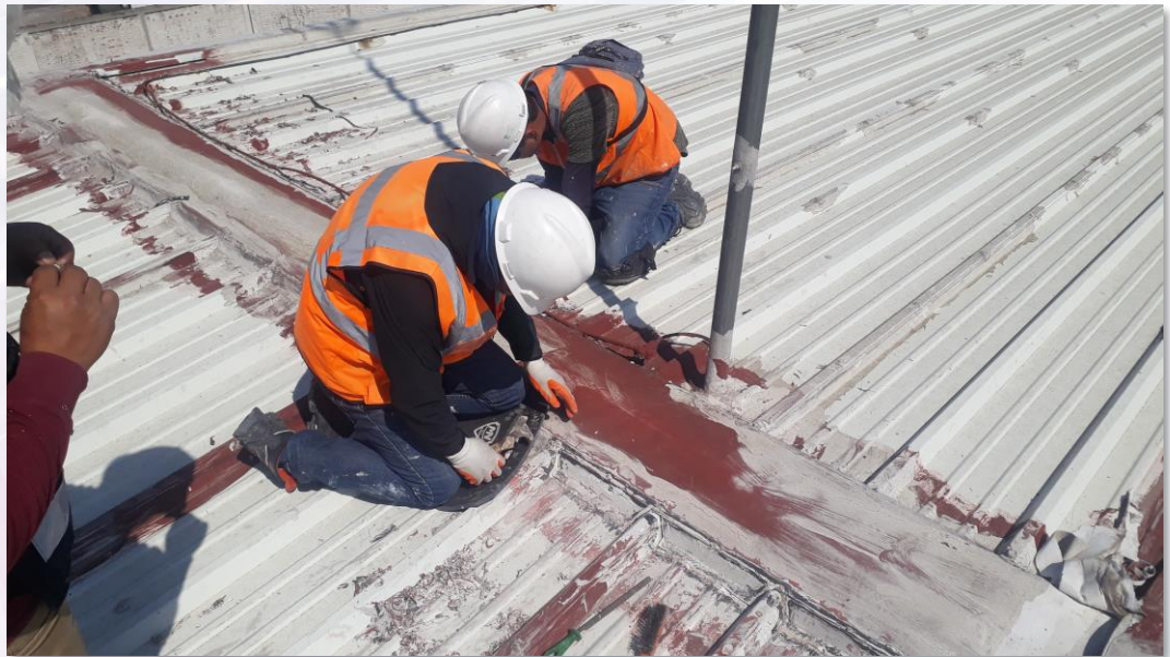
Cubierta durante los trabajos de limpieza
