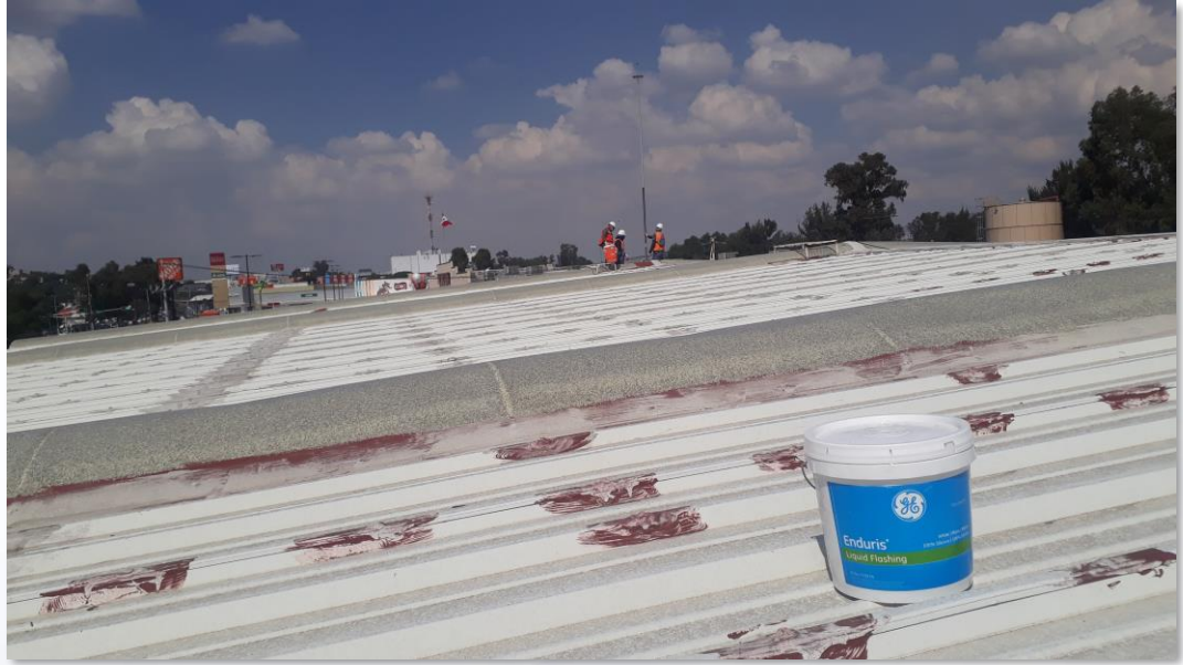
Aplicación de Enduris* Liquid Flashing
