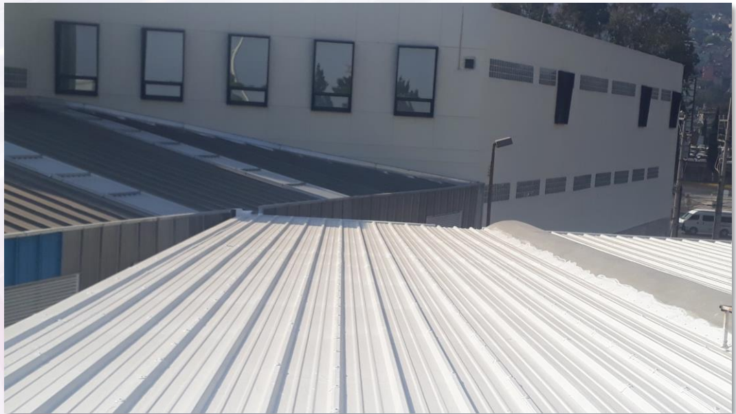
Cubierta terminada con Sistema Enduris*
