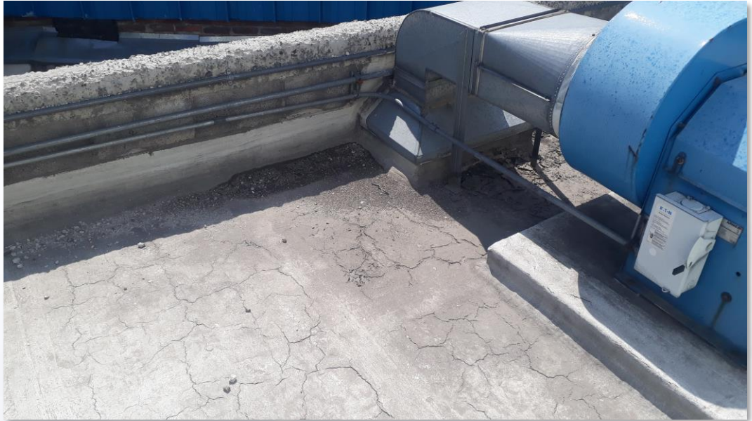
Cubierta antes de los trabajos de limpieza
