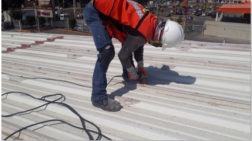
Cubierta durante los trabajos de limpieza
