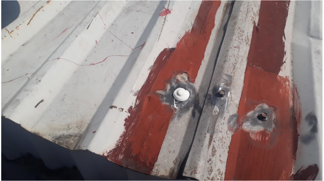
Aplicación de Enduris* Liquid Flashing
