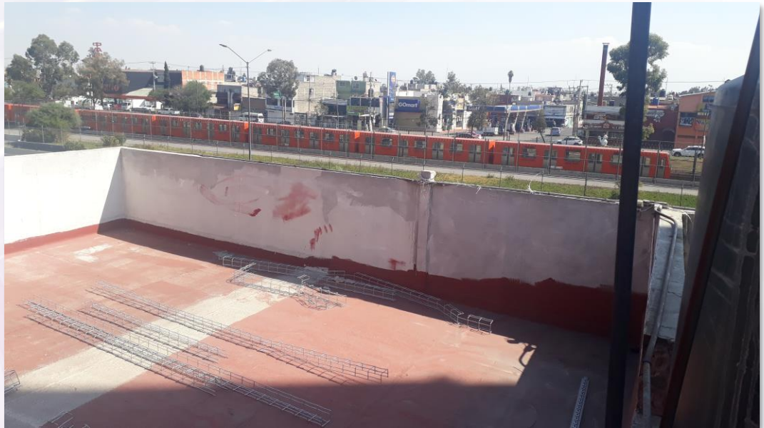
Cubierta durante los trabajos de limpieza
