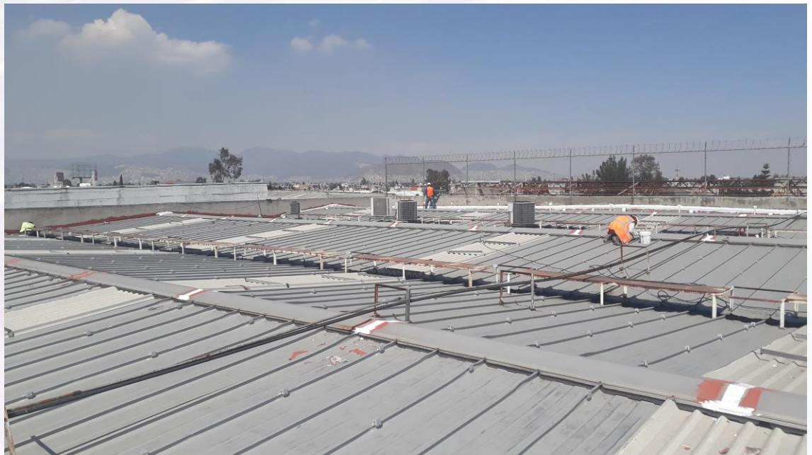
Aplicación de Enduris* Liquid Flashing
