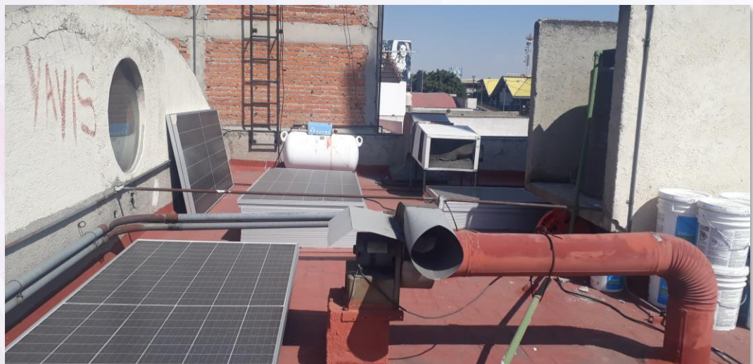
Cubierta antes de los trabajos de limpieza
