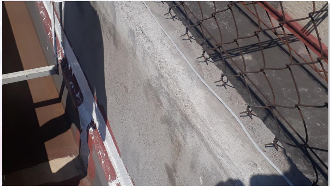
Cubierta después de los trabajos de limpieza
