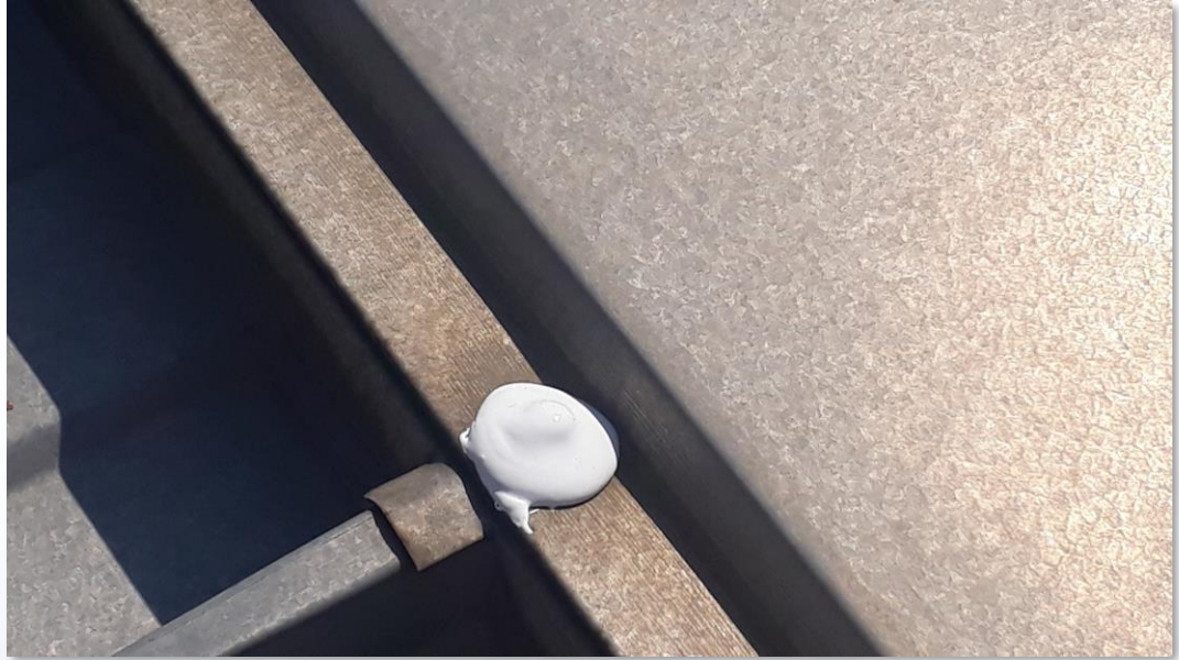
Aplicación de Enduris* Liquid Flashing
