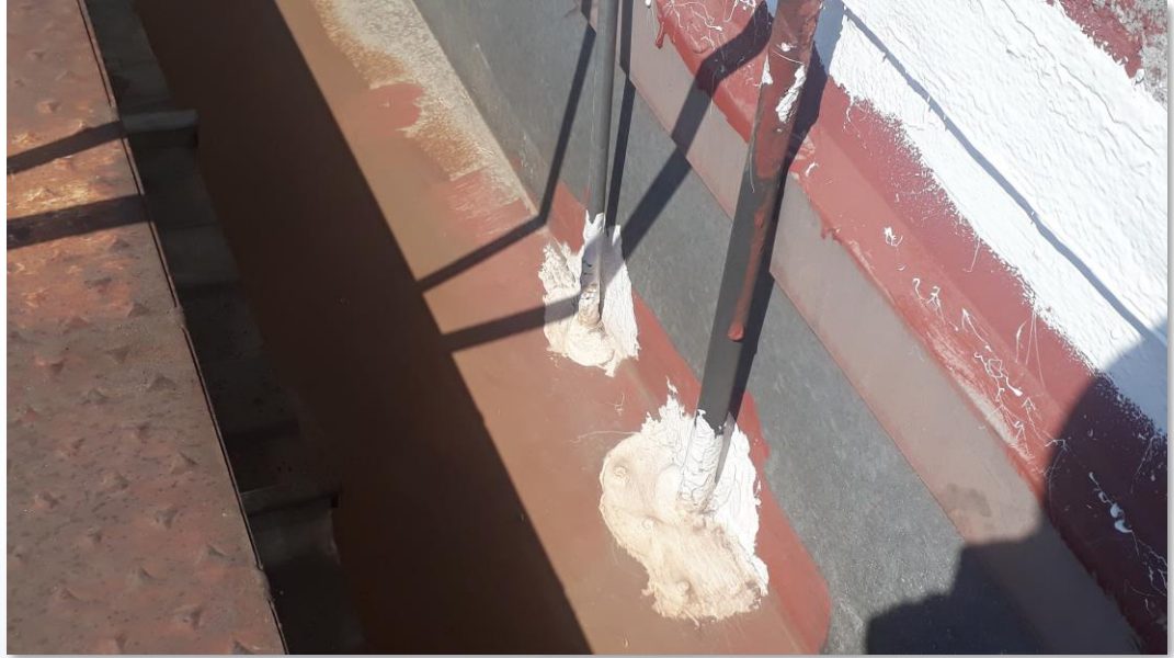
Aplicación de Enduris* Liquid Flashing
