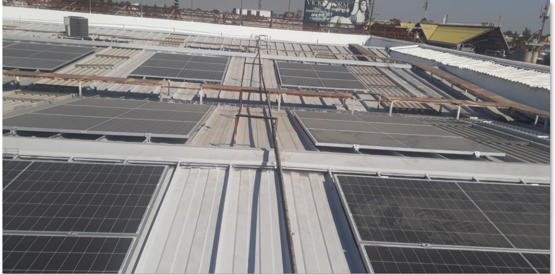
Cubierta terminada con Sistema Enduris*
