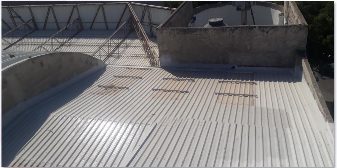
Cubierta terminada con Sistema Enduris*
