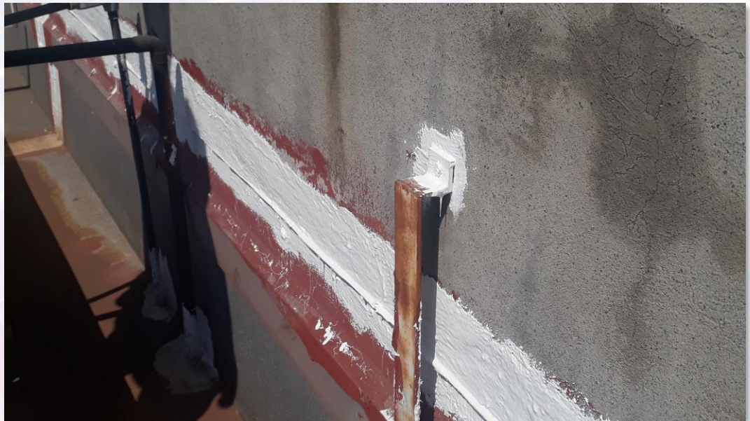
Aplicación de Enduris* Liquid Flashing
