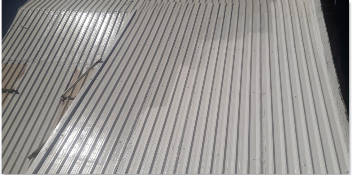
Cubierta terminada con Sistema Enduris*
