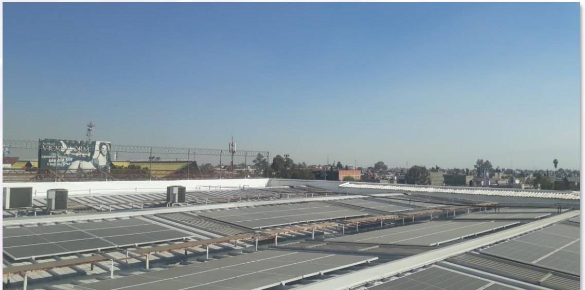
Cubierta terminada con Sistema Enduris*
