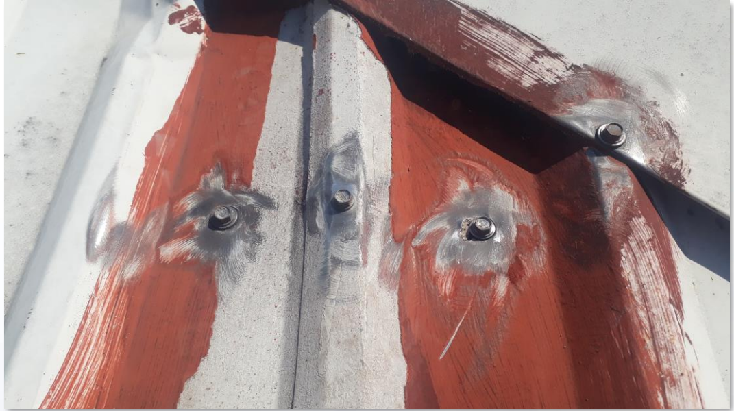
Cubierta durante los trabajos de limpieza
