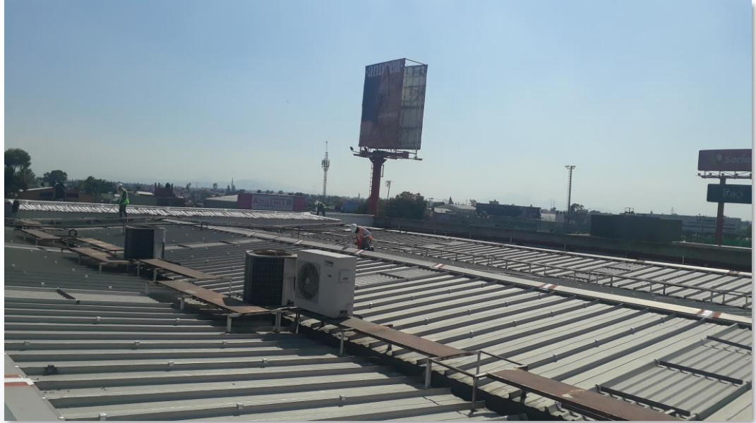
Cubierta antes de los trabajos de limpieza
