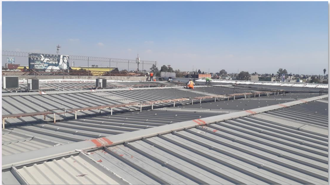
Cubierta antes de los trabajos de limpieza
