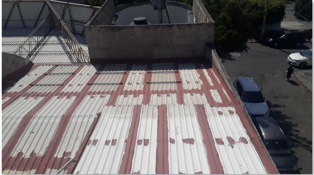
Cubierta antes de los trabajos de limpieza
