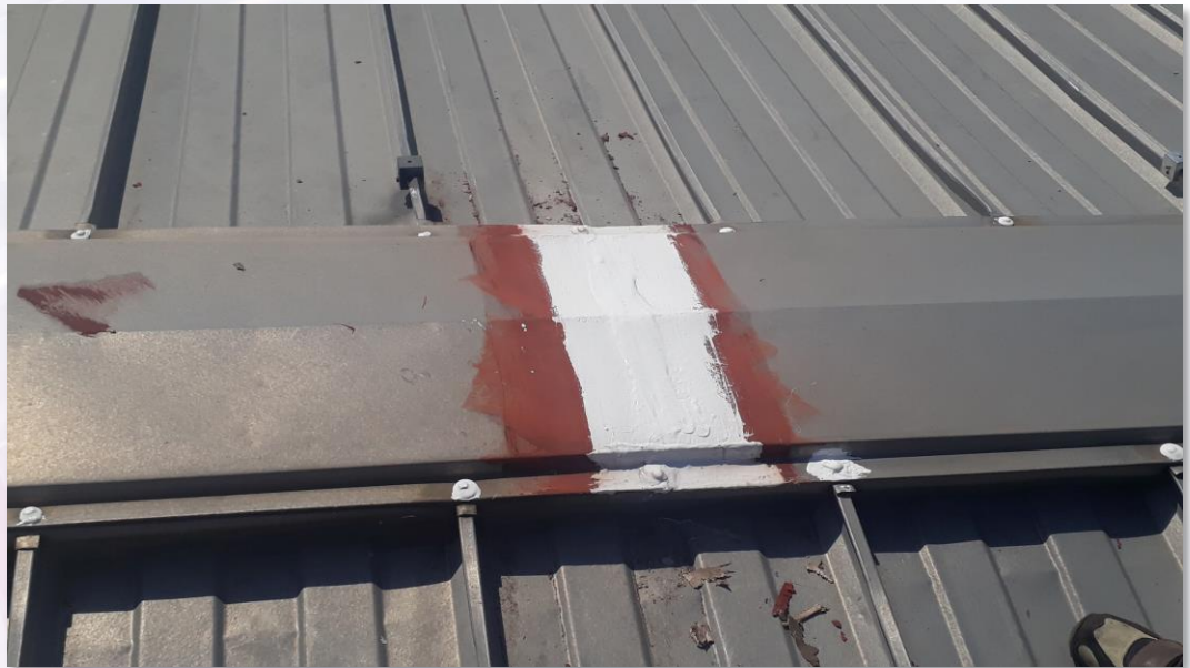
Aplicación de Enduris* Liquid Flashing
