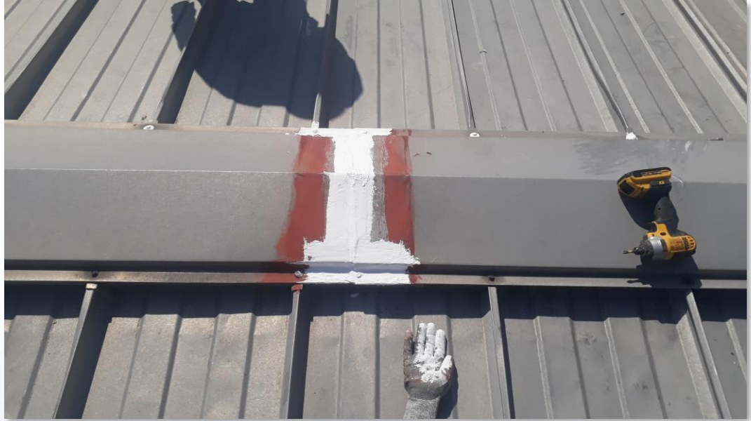
Aplicación de Enduris* Liquid Flashing
