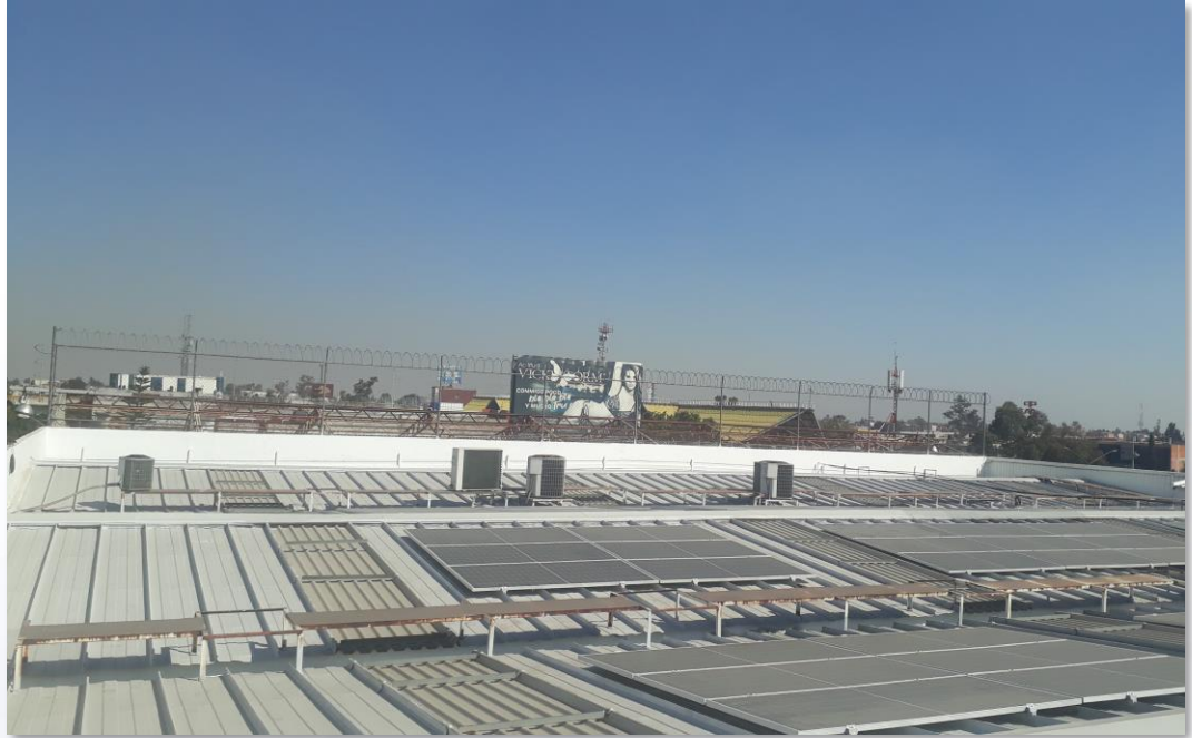
Cubierta terminada con Sistema Enduris*
