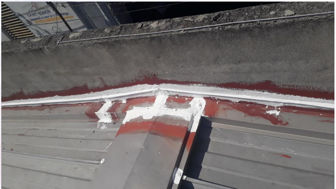
Aplicación de Enduris* Liquid Flashing
