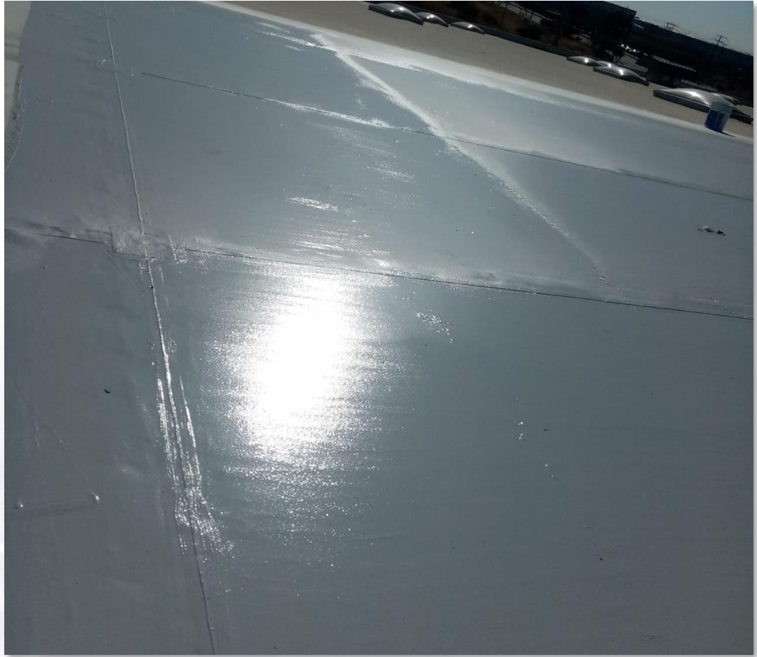
Cubierta terminada con Sistema Enduris*
