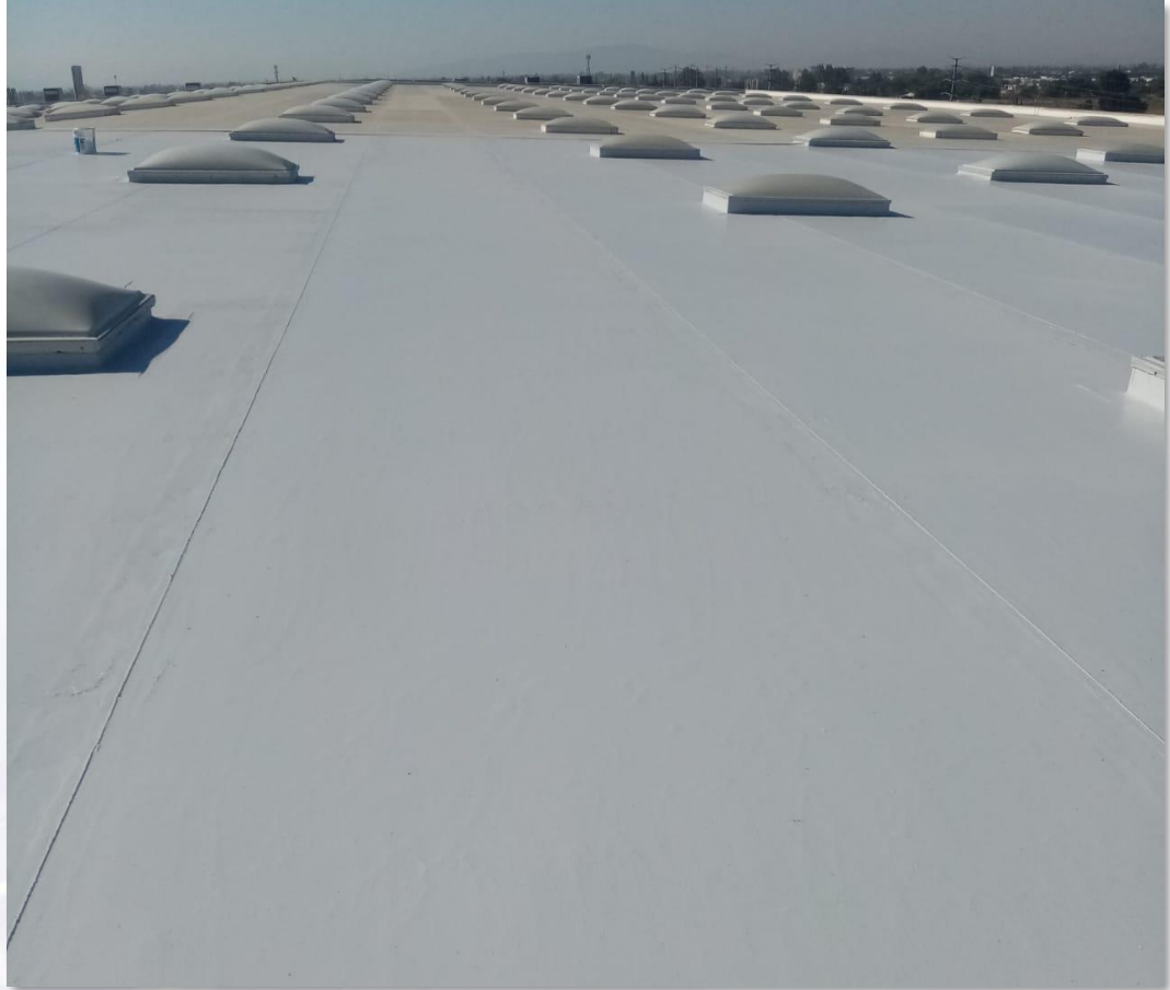
Cubierta terminada con Sistema Enduris*
