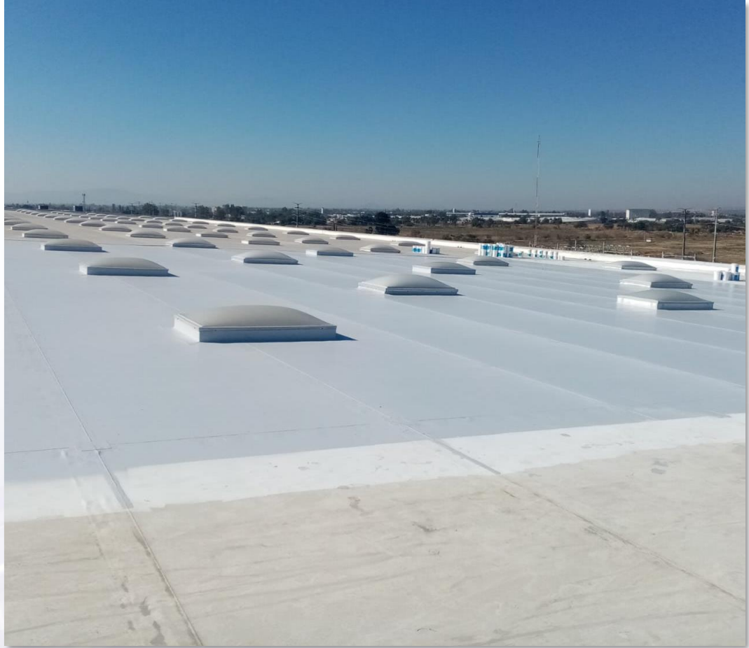
Cubierta terminada con Sistema Enduris*
