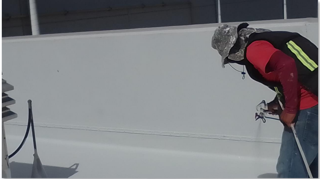
Aplicación del Sistema Enduris* con Equipo Airless
