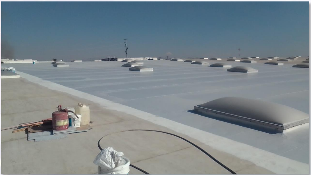
Cubierta terminada con Sistema Enduris*
