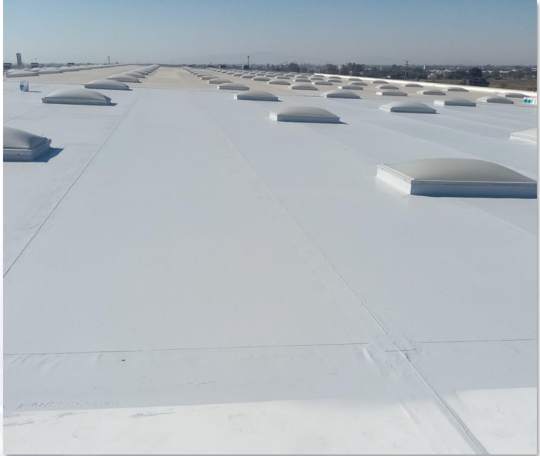
Cubierta terminada con Sistema Enduris*
