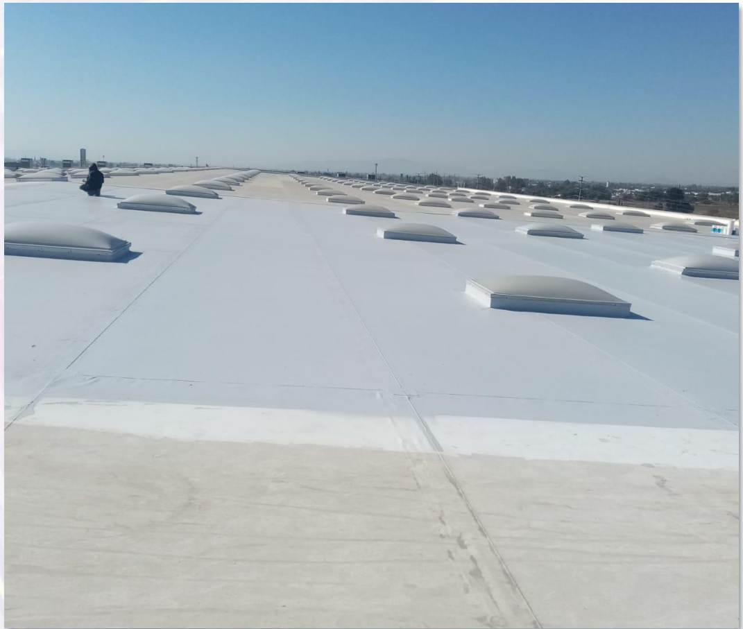
Cubierta terminada con Sistema Enduris*
