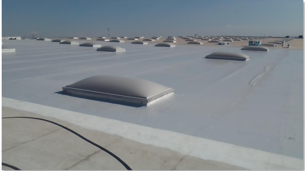
Cubierta terminada con Sistema Enduris*
