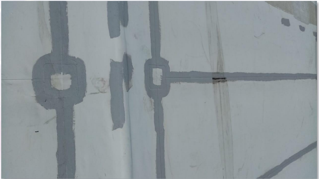
Aplicación de Enduris* a 60 mils en puntos críticos
