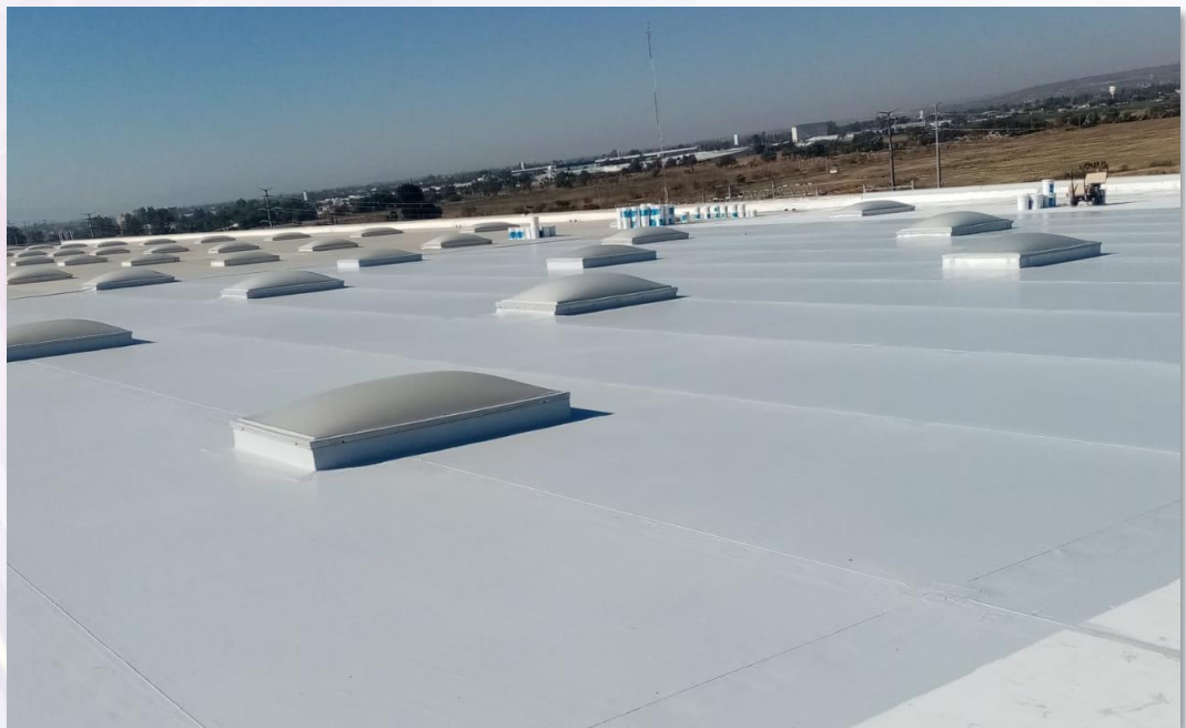
Cubierta terminada con Sistema Enduris*
