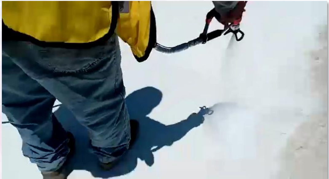
Aplicación de Sistema Enduris* con equipo Airless
