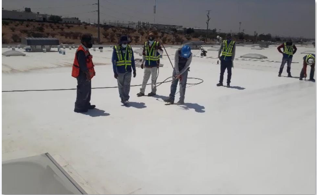
Aplicación de Sistema Enduris* con equipo Airless
