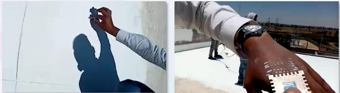
Medición de espesores en fresco
