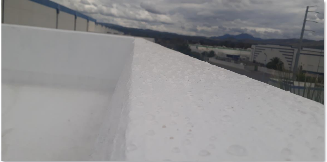
Cubierta terminada con Sistema Enduris*
