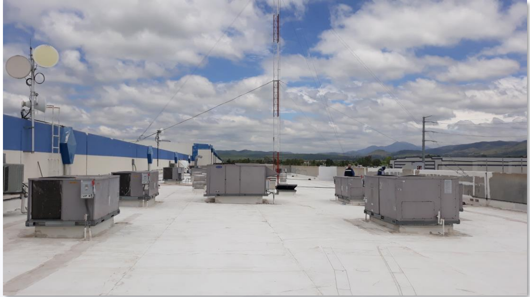
Cubierta después de los trabajos de limpieza
