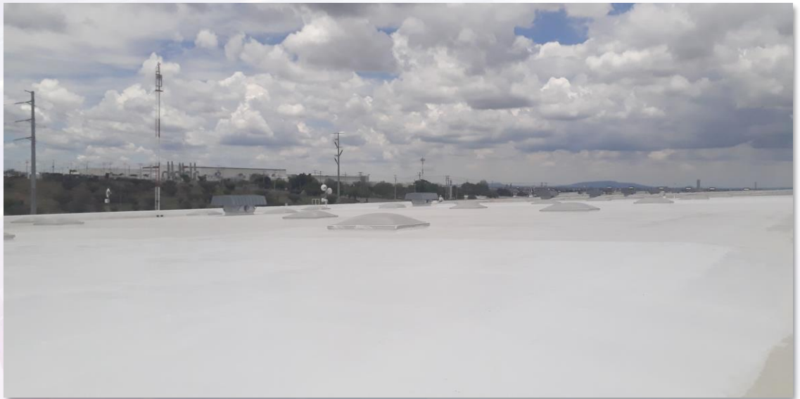
Cubierta terminada con Sistema Enduris*
