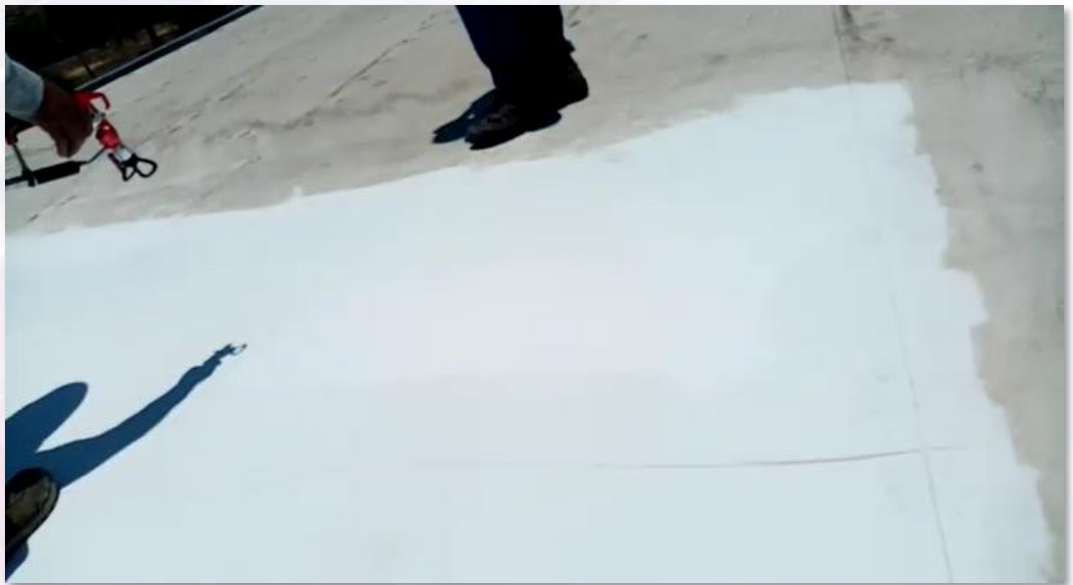
Aplicación de Sistema Enduris* con equipo Airless
