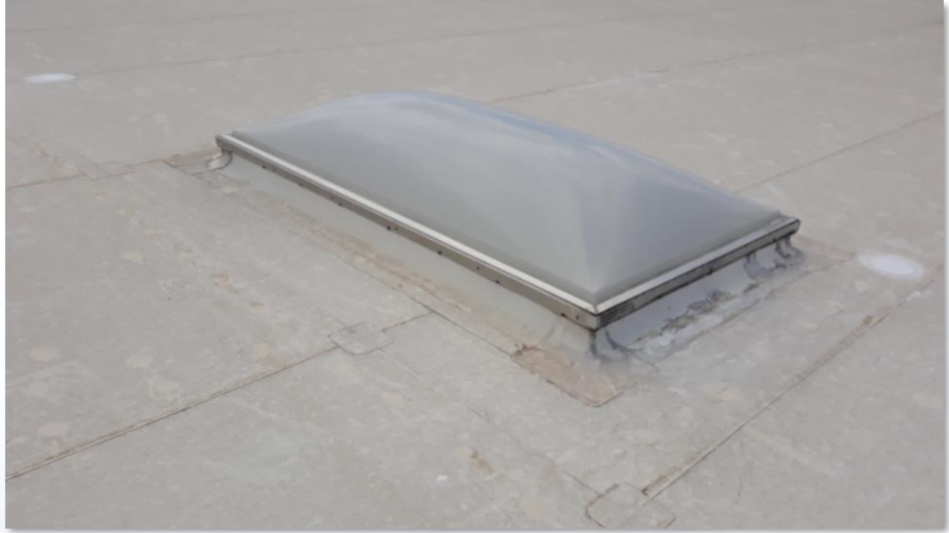
Cubierta antes de los trabajos de limpieza
