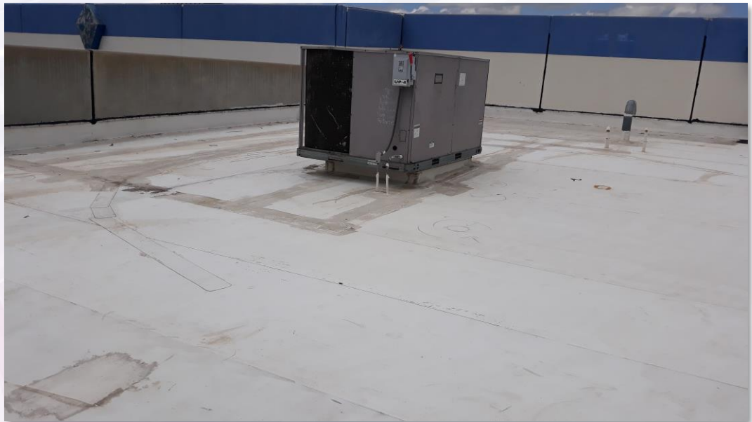
Cubierta después de los trabajos de limpieza
