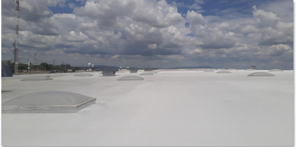
Cubierta terminada con Sistema Enduris*
