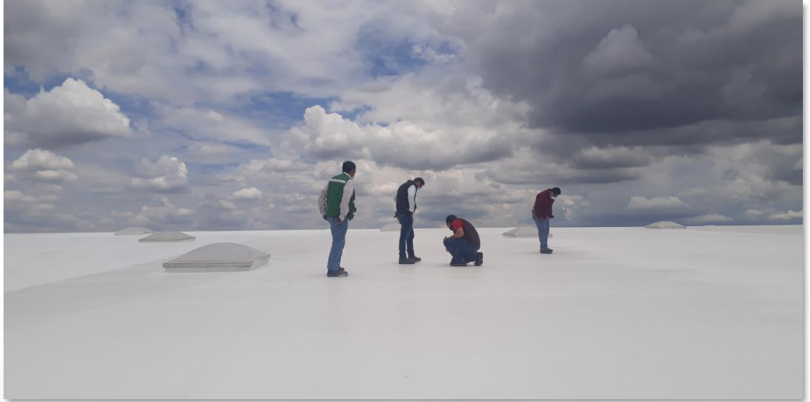
Cubierta terminada con Sistema Enduris*
