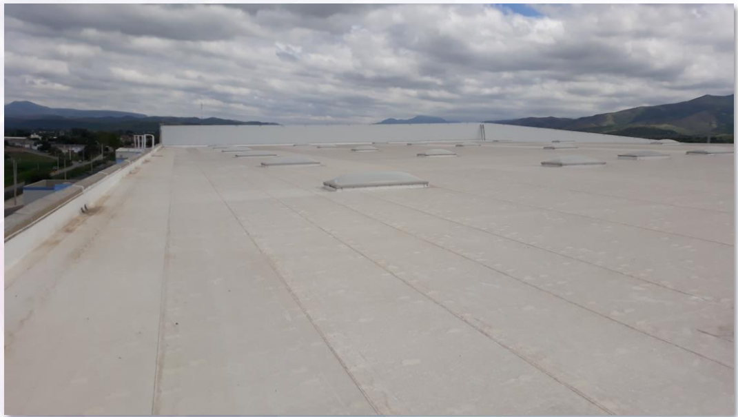
Cubierta antes de los trabajos de limpieza
