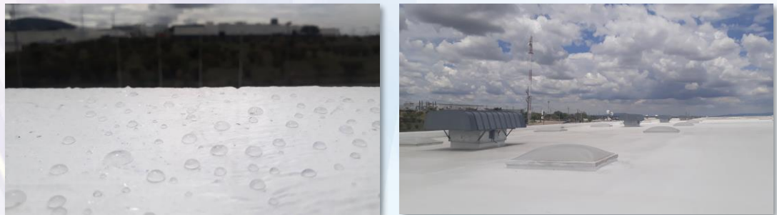
Superficie recubierta de Enduris* 3502
