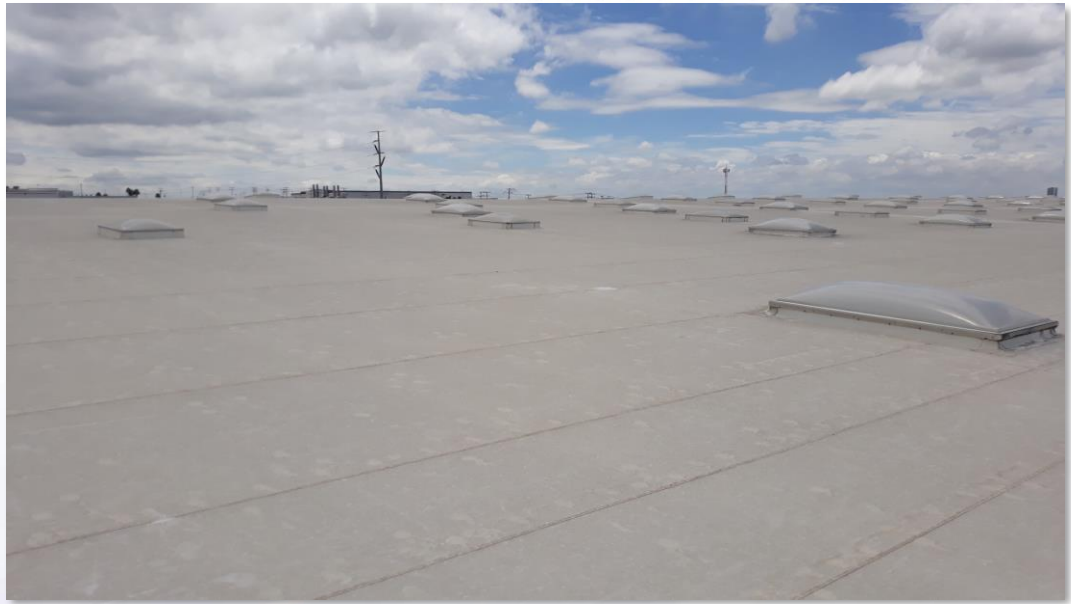
Cubierta antes de los trabajos de limpieza
