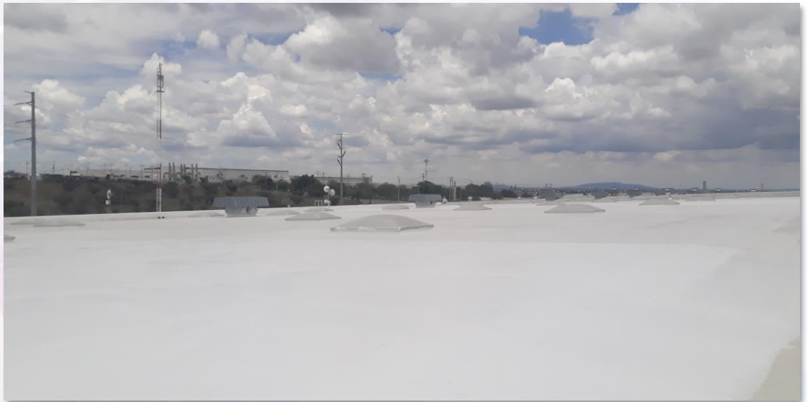
Cubierta terminada con Sistema Enduris*
